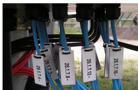
2. connessioni in corrente alternata (bassa tensione)
