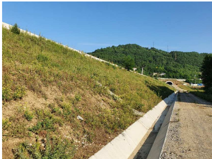
Figura 87: area di cantiere VEG-SS-500D
