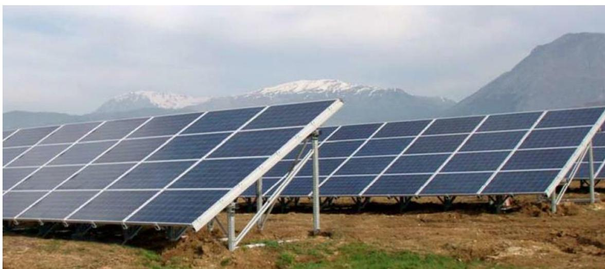
**Figura 2-1 – INSTALLAZIONE CON 4 MODULI IN ORIZZONTALE SU STRUTTURA FISSA**
