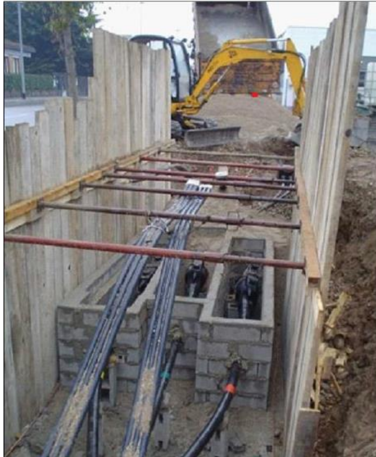
FIGURA 7: DETTAGLIO TIPOLOGICI DI BUCA GIUNTI
