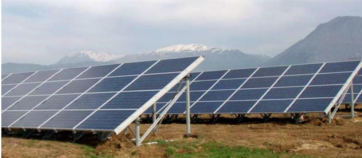
Esempio di struttura di sostegno per quattro file orizzontali di moduli fotovoltaici affiancati
