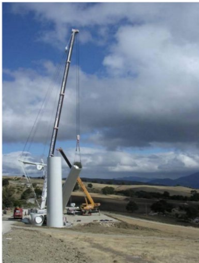
Figura 24 – Fasi di montaggio della torre dell'aerogeneratore.
