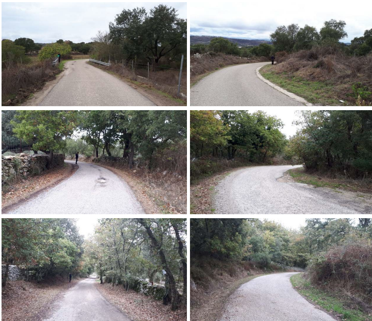
Figura 3 – Vista della strada comunale da Prato Sardo alla S.P. 41 di larghezza complessiva sempre pari ad almeno 5 m, grazie alla presenza di banchine inerbite laterali, oltre alla parte pavimentata di larghezza 3 m.
