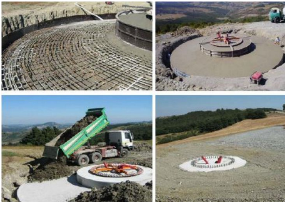
Figura 17 – Fasi di realizzazione del plinto di fondazione dell'aerogeneratore.
