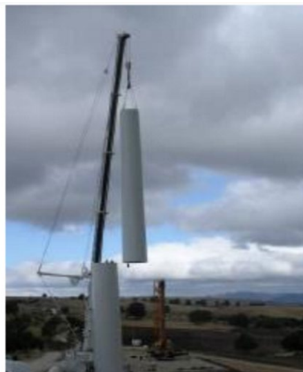
Figura 24 – Fasi di montaggio della torre dell'aerogeneratore.
