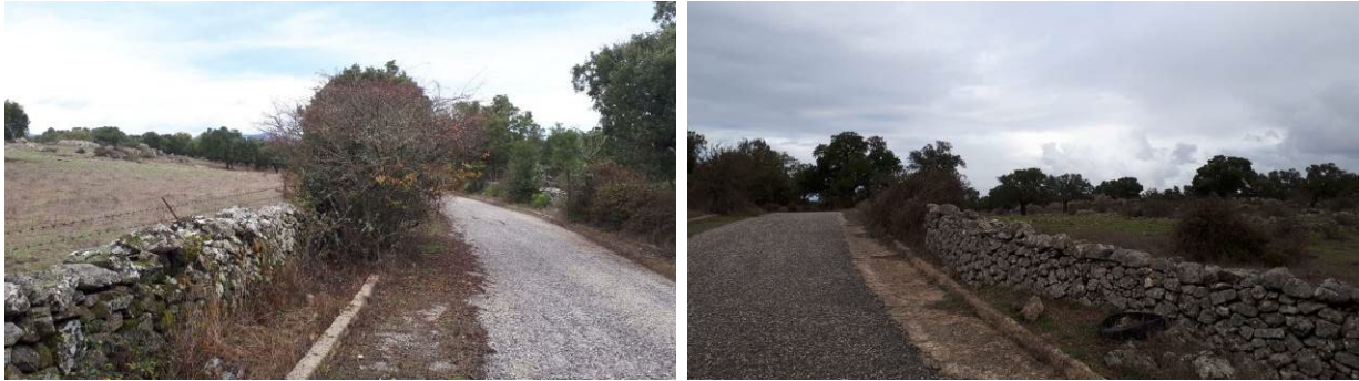
Figura 4 – Vista della strada comunale da Prato Sardo alla S.P. 41 di larghezza complessiva sempre pari ad almeno 5 m, grazie alla presenza di banchine inerbite laterali, oltre alla parte pavimentata di larghezza 3 m. I muretti a secco presenti sono sempre a una distanza dalla careggiata, tale da garantire almeno 5 m di larghezza utile per il passaggio dei mezzi.
