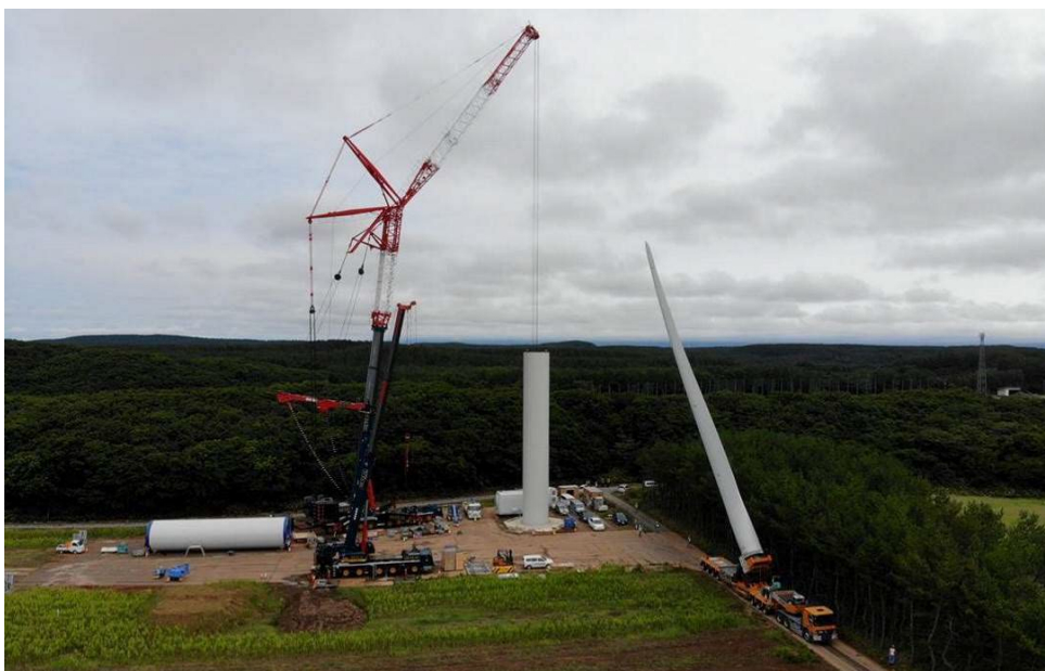
Figura 14 – Fasi di montaggio della torre dell'aerogeneratore.
