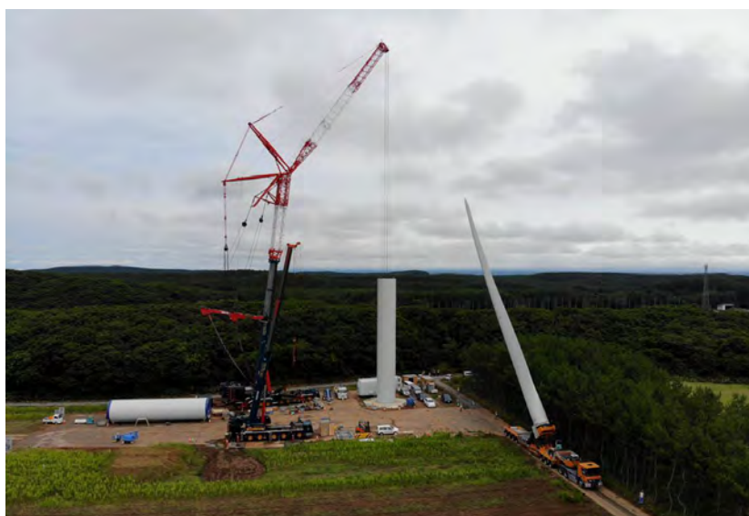
Figura 4 – Montaggio dell'aerogeneratore con gru principale.
