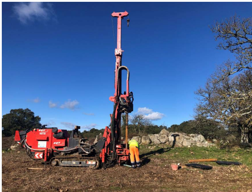
Figura 5 – Esecuzione del sondaggio nel sito dove è prevista la posa dell'aerogeneratore WTG 010
