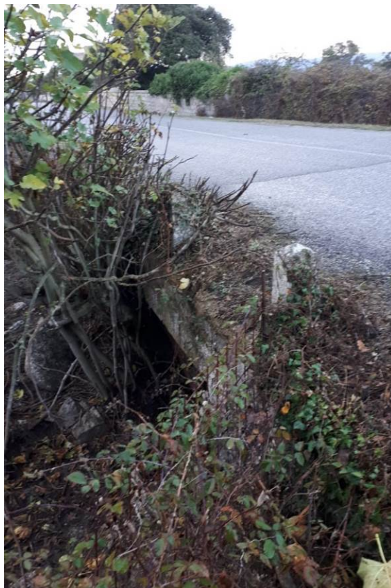
Figura 16 – Manufatto di attraversamento lungo Strada Provinciale 41 su corso d'acqua secondario (03_SP41_02)
