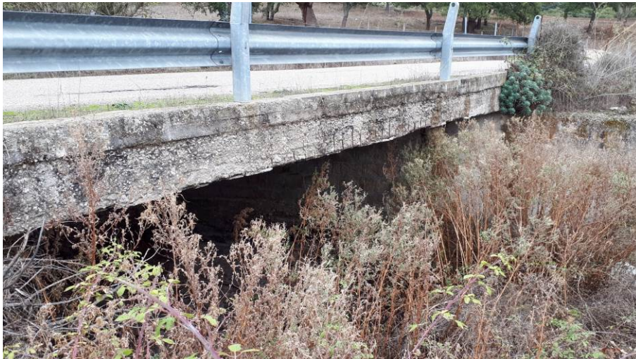
Figura 8 – Manufatto che consente l'attraversamento del Riu Funtana Grasones lungo Strada Comunale Nuoro (02_SCN_02)
