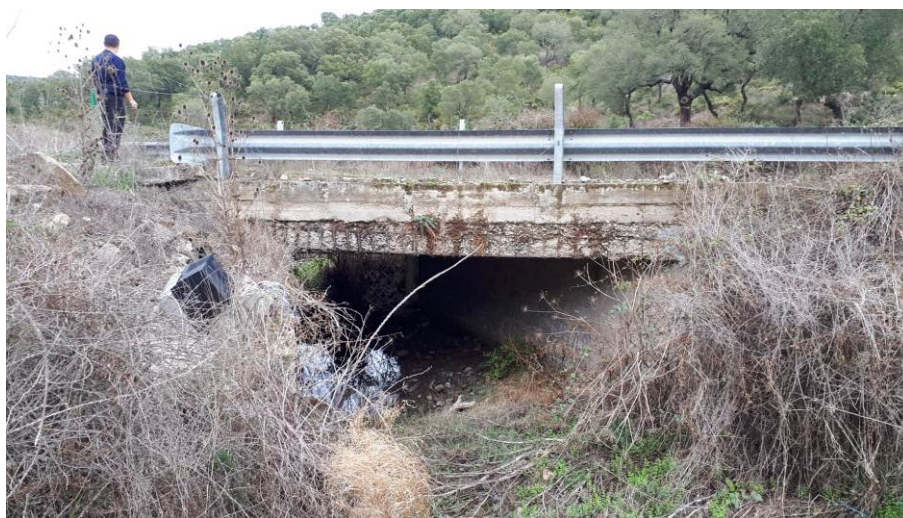
Figura 10 – Manufatto di attraversamento sul Riu Salavrache lungo Strada Comunale Nuoro (02_SCN_03)
