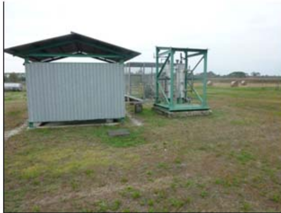
5) Interno dell'area del pozzo
