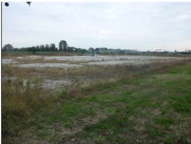
6) Interno dell'area recintata
