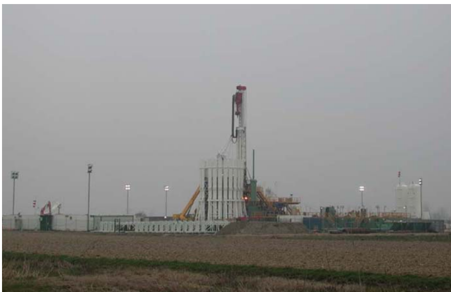
Figura 8.1.b – Impianto HH220 “Archimede” - perforazione del pozzo Ripalta 62 Or
