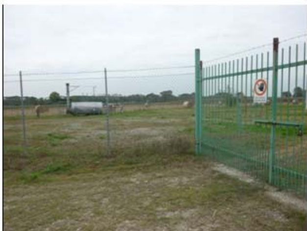
2) Ingresso all'area del pozzo 18
