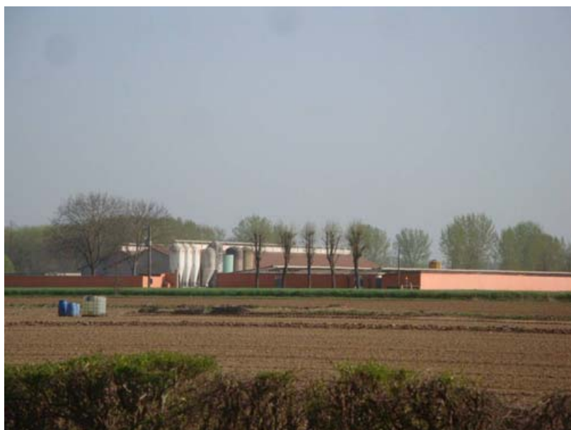
Figura 8.1.d – Ripalta Cremasca, insediamento produttivo in aperta campagna
