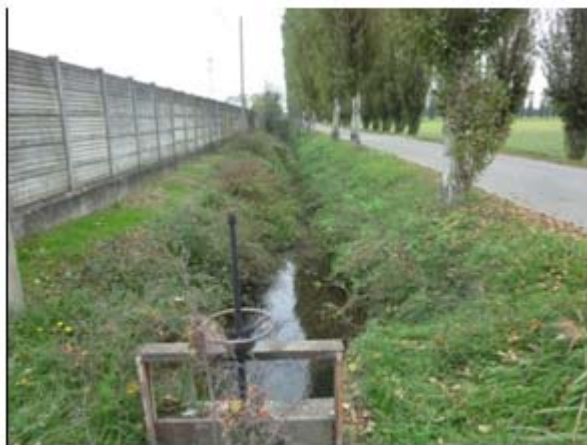
7) Il fosso che bordo verso S i terreni dell'impianto di trattamento e del cluster A
