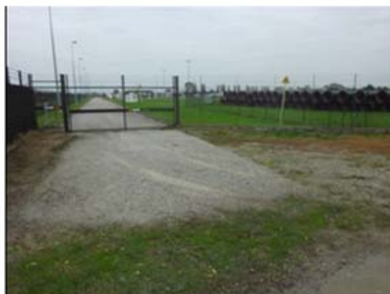
11) Ingresso secondario della Centrale di compressione
