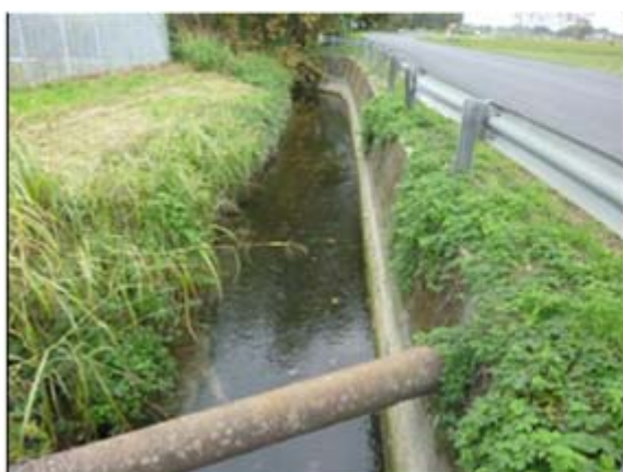
3a) Il canale che decorre lungo il lato orientale
