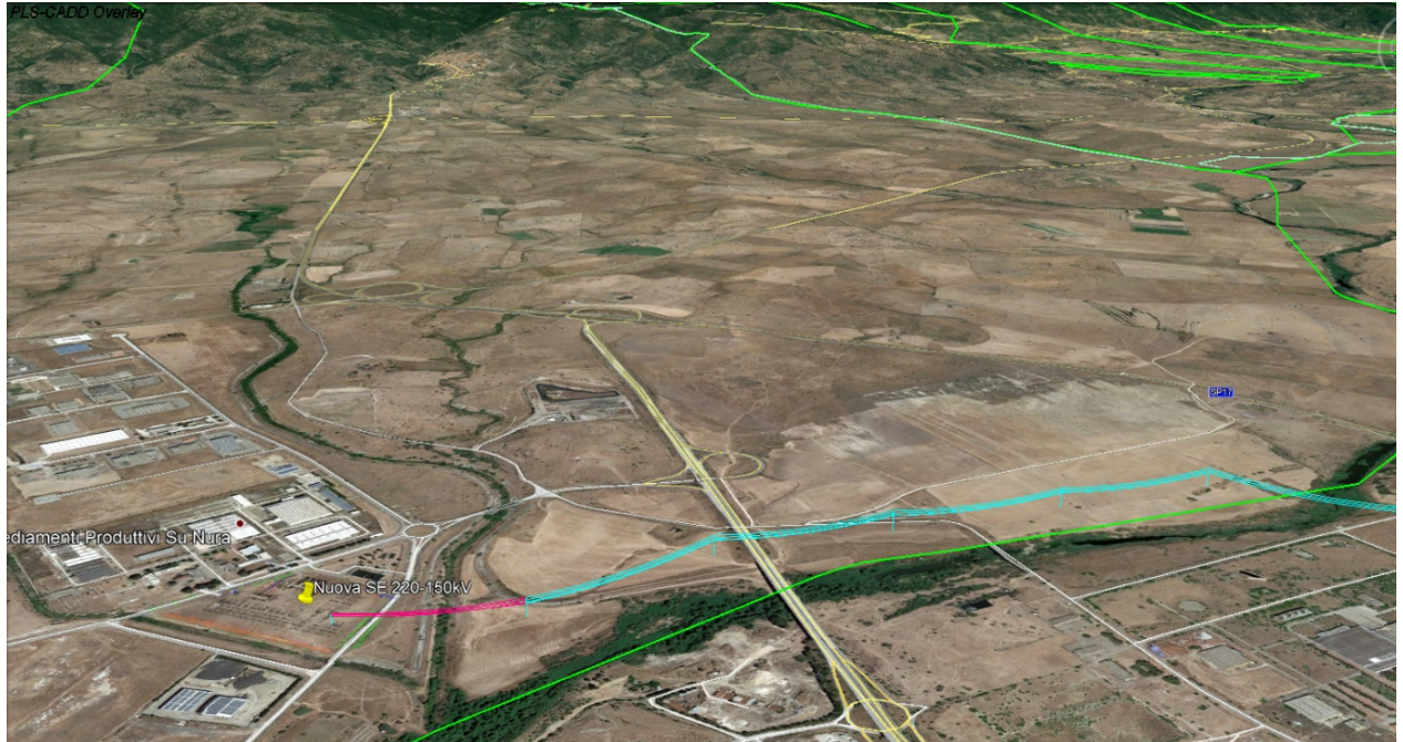
Linea "SE Ottana – SE Nuoro" parte comune – attraversamento Comune di Bolotana (km 0+000 – 1+645)
