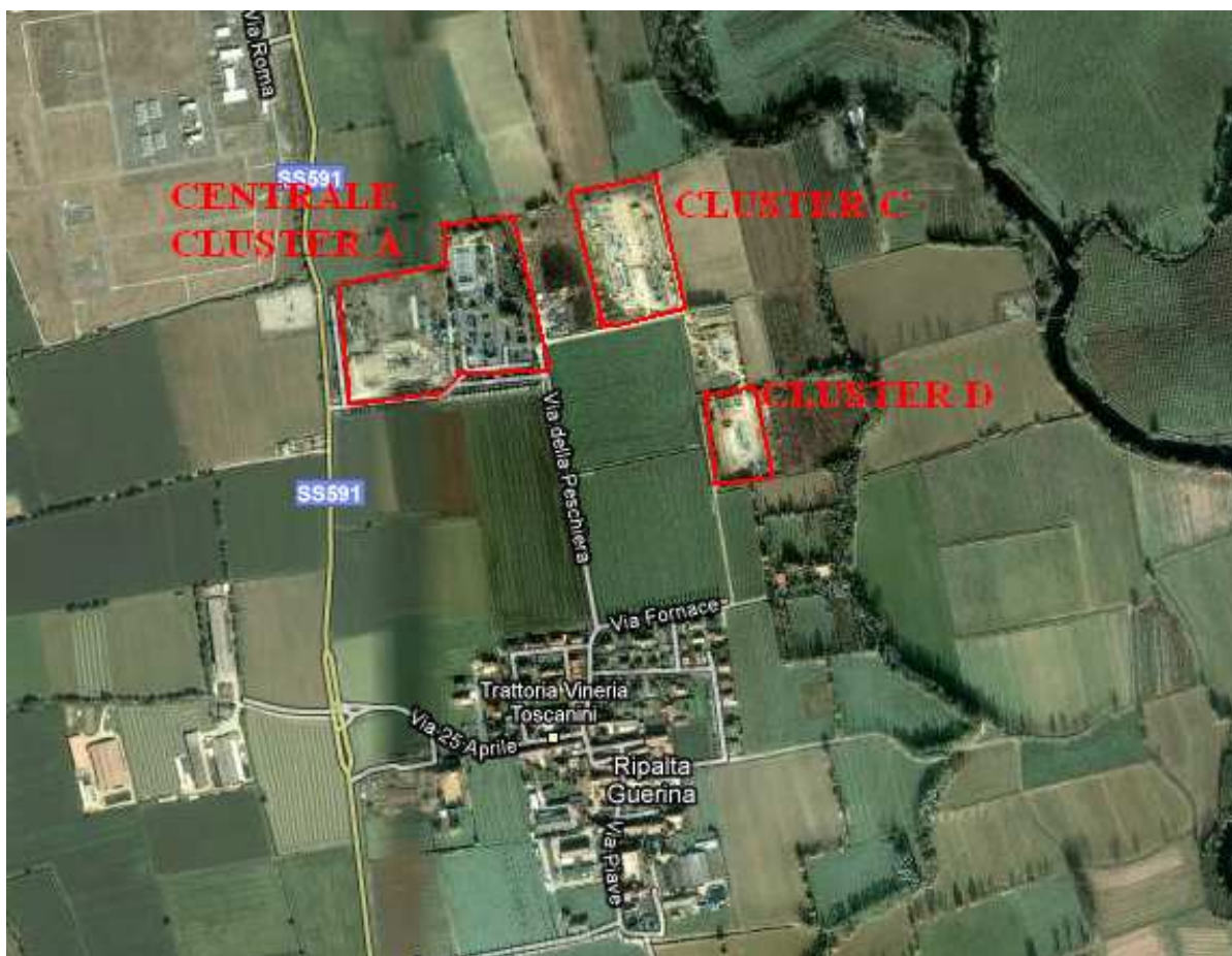
Figura 2 – Vista aerea dell’Impianto di Trattamento – Sito di Ripalta
