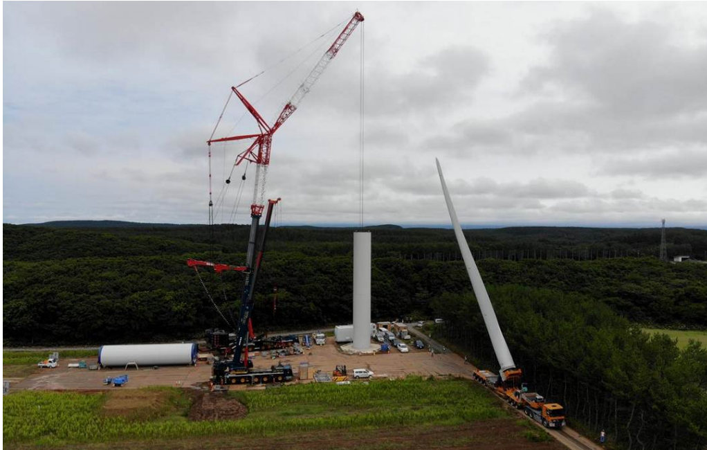
Figura 29 – Fasi di montaggio della torre dell'aerogeneratore
