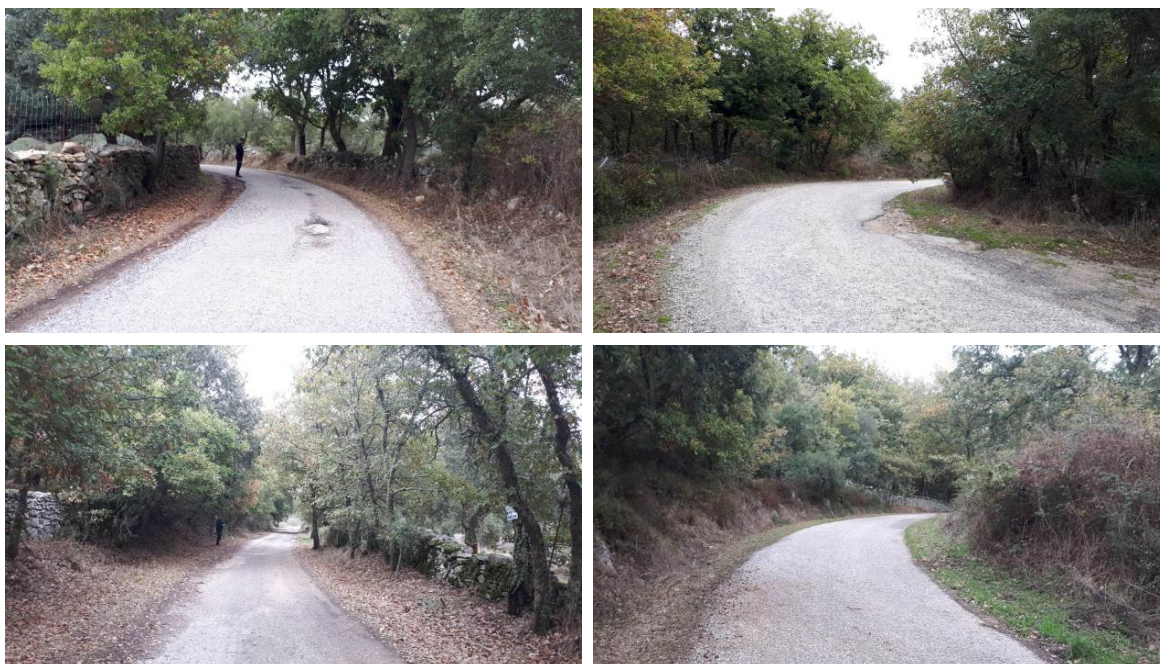
Figura 3 – Vista della strada comunale da Prato Sardo alla S.P. 41 di larghezza complessiva sempre pari ad almeno 5 m, grazie alla presenza di banchine inerbite laterali, oltre alla parte pavimentata di larghezza 3 m.
