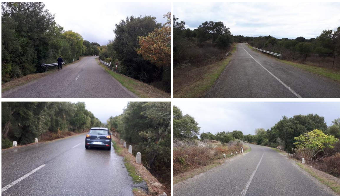
Figura 5 – Vista della strada provinciale S.P. 41 di larghezza utile > 7 m.
