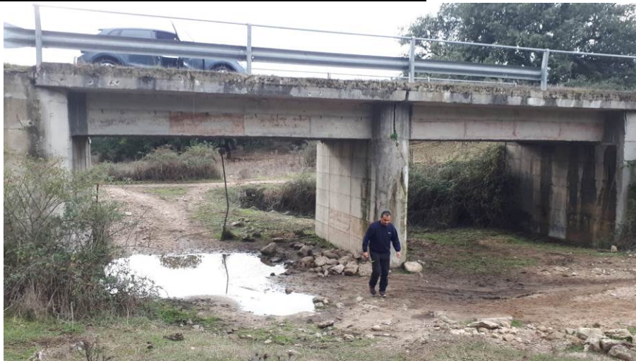
Figura 15 – Manufatto di attraversamento sul Riu de Gantinesinis lungo Strada Comunale Nuoro (02_SCN_04).
