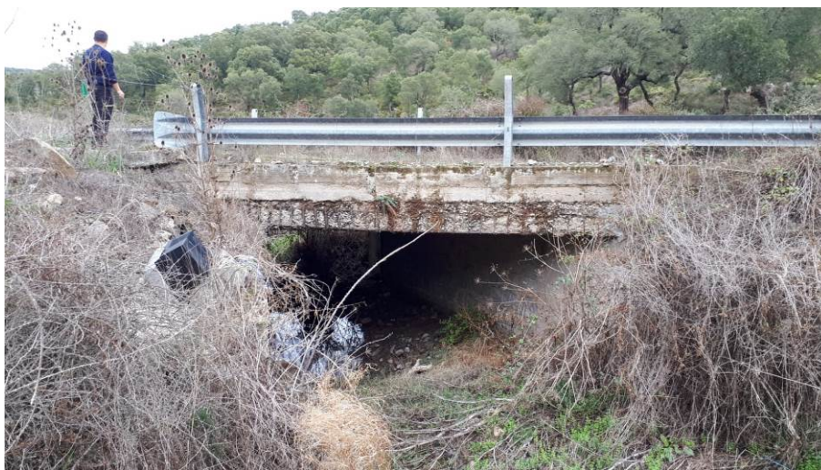
Figura 13 – Manufatto di attraversamento sul Riu Salavriche lungo Strada Comunale Nuoro (02_SCN_03)
