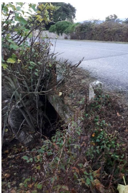
Figura 19 – Manufatto di attraversamento lungo Strada Provinciale 41 su corso d'acqua secondario (03_SP41_02)
