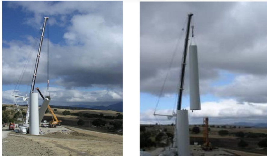
Figura 41 – Fasi di montaggio della torre dell'aerogeneratore
