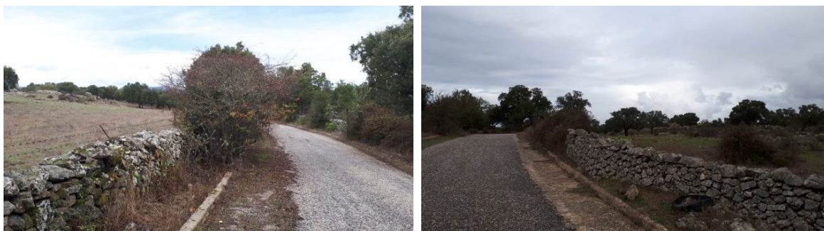
Figura 4 – Vista della strada comunale da Prato Sardo alla S.P. 41 di larghezza complessiva sempre pari ad almeno 5 m, grazie alla presenza di banchine inerbite laterali, oltre alla parte pavimentata di larghezza 3 m. I muretti a secco presenti sono sempre a una distanza dalla carreggiata, tale da garantire almeno 5 m di larghezza utile per il passaggio dei mezzi.
