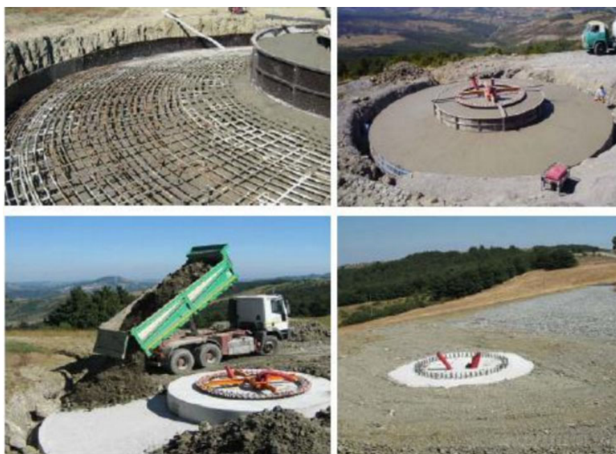
Figura 33 – Fasi di realizzazione del plinto di fondazione dell'aerogeneratore
