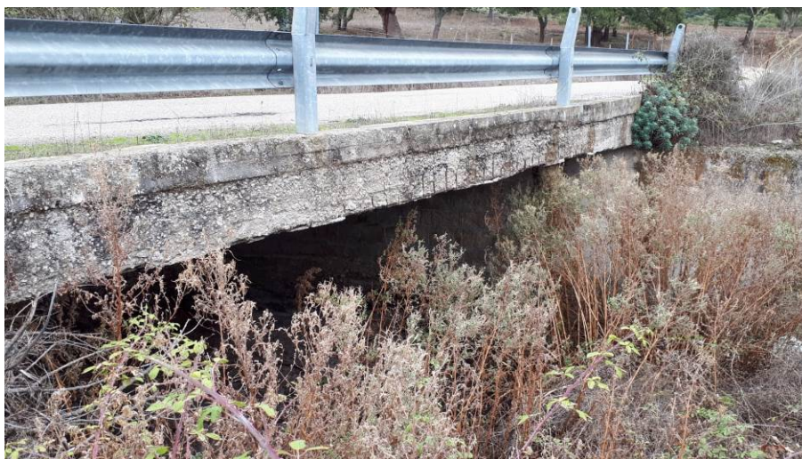
Figura 11 – Manufatto che consente l'attraversamento del Riu Funtana Grasones lungo Strada Comunale Nuoro (02_SCN_02)
