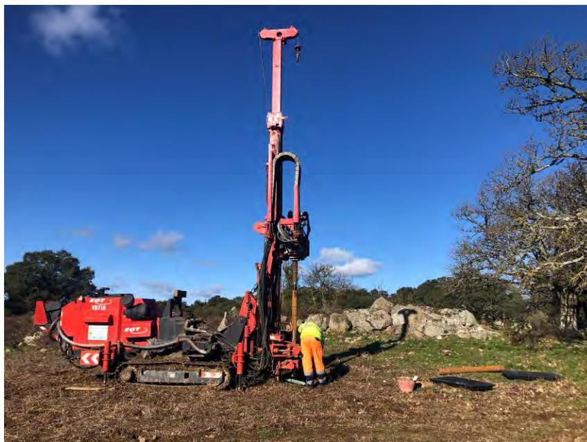
Figura 19 – Esecuzione del sondaggio nel sito dove è prevista la posa dell'aerogeneratore WTG 010
