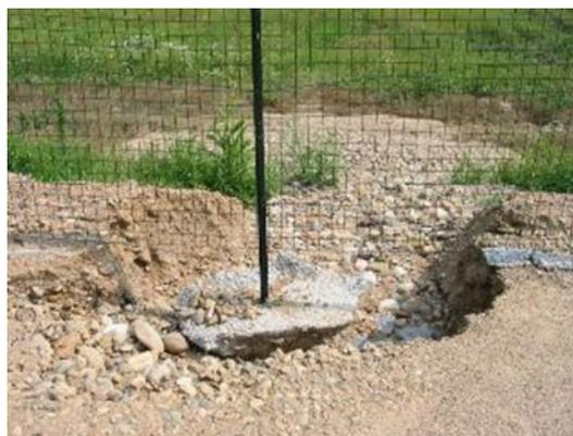
*Figura 6 Fenomeni di erosione nei cantieri*
