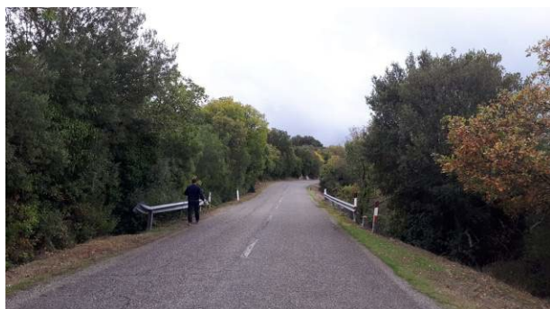
Figura 6 - Vista della strada comunale da Prato Sardo alla S.P. 41 di larghezza complessiva sempre pari ad almeno 5 m, grazie alla presenza di banchine inerbite laterali, oltre alla parte pavimentata di larghezza 3 m. I muretti a secco presenti sono sempre a una distanza dalla carreggiata, tale da garantire almeno 5 m di larghezza utile per il passaggio dei mezzi
