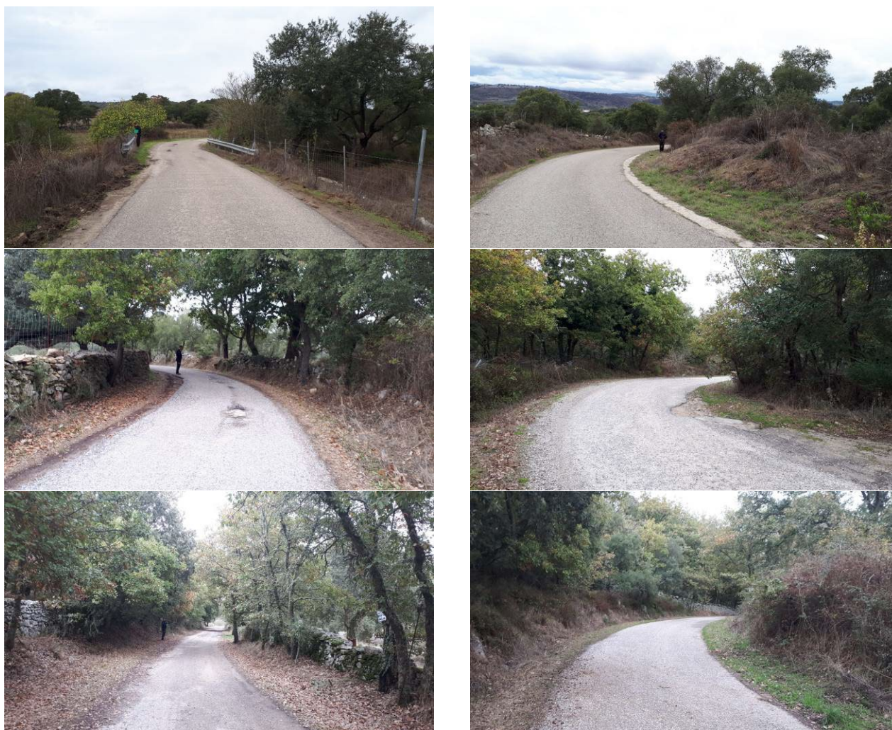
Figura 5 – Vista della strada comunale da Prato Sardo alla S.P. 41 di larghezza complessiva sempre pari ad almeno 5 m, grazie alla presenza di banchine inerbite laterali, oltre alla parte pavimentata di larghezza 3 m
