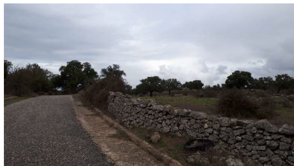
Figura 6 - Vista della strada comunale da Prato Sardo alla S.P. 41 di larghezza complessiva sempre pari ad almeno 5 m, grazie alla presenza di banchine inerbite laterali, oltre alla parte pavimentata di larghezza 3 m. I muretti a secco presenti sono sempre a una distanza dalla carreggiata, tale da garantire almeno 5 m di larghezza utile per il passaggio dei mezzi
