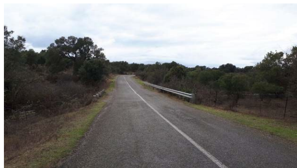
Figura 6 - Vista della strada comunale da Prato Sardo alla S.P. 41 di larghezza complessiva sempre pari ad almeno 5 m, grazie alla presenza di banchine inerbite laterali, oltre alla parte pavimentata di larghezza 3 m. I muretti a secco presenti sono sempre a una distanza dalla carreggiata, tale da garantire almeno 5 m di larghezza utile per il passaggio dei mezzi
