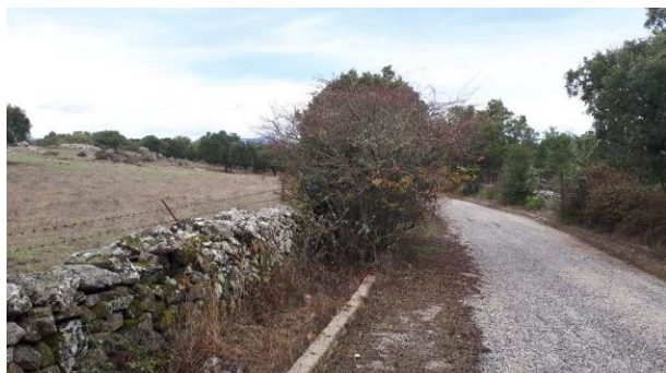
Figura 6 - Vista della strada comunale da Prato Sardo alla S.P. 41 di larghezza complessiva sempre pari ad almeno 5 m, grazie alla presenza di banchine inerbite laterali, oltre alla parte pavimentata di larghezza 3 m. I muretti a secco presenti sono sempre a una distanza dalla carreggiata, tale da garantire almeno 5 m di larghezza utile per il passaggio dei mezzi
