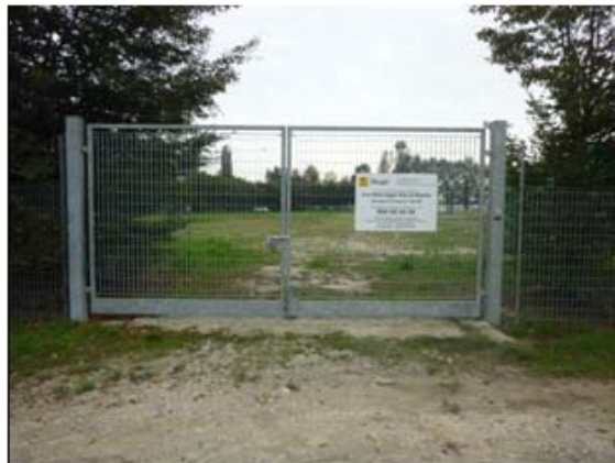
4) Ingresso al cluster D, da Nord
