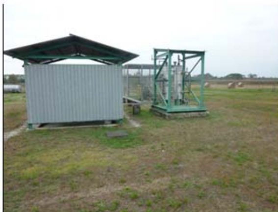
5) Interno dell'area del pozzo
