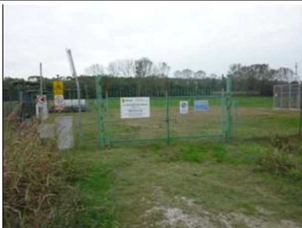
1) Ingresso all'area del pozzo 9
