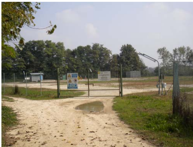
Figura 7.1.b – Pozzi Ripalta 27 e 61: vista presso l'ingresso dell'impianto
