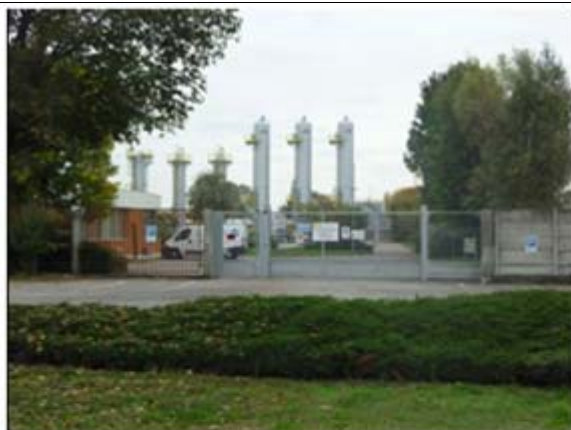
1) Ingresso dell'impianto di trattamento
