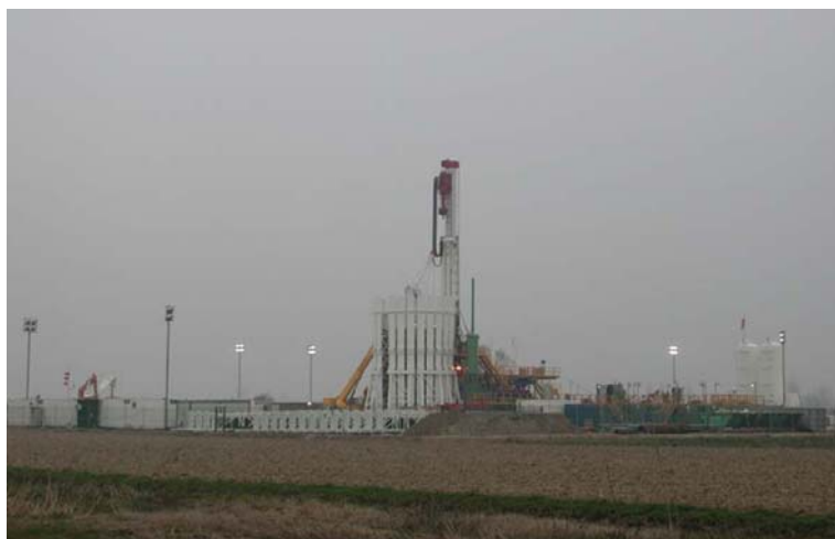
Figura 7.1.c – Impianto HH220 “Archimede” - perforazione del pozzo Ripalta 62 Or
