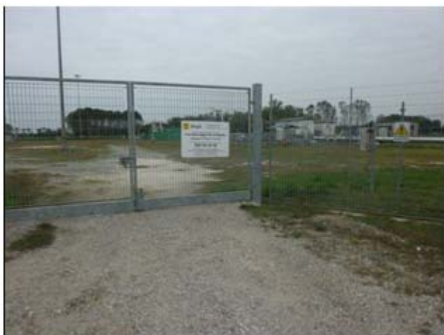
1) Ingresso del Cluster C
