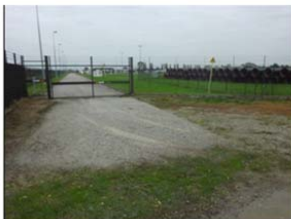
11) Ingresso secondario della Centrale di compressione
