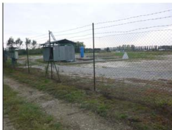
4) Interno dell'area dei pozzi
