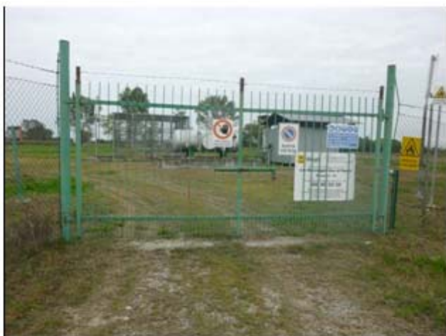
1) Ingresso all'area del pozzo 18
