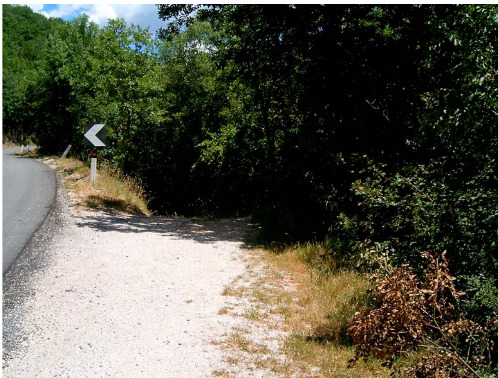
Foto 10 – Innesto della pista dalla SP Poggio Sorifa – Laverino sul versante in destra idrografica dell'Alto Potenza (Valle delle Vene)
