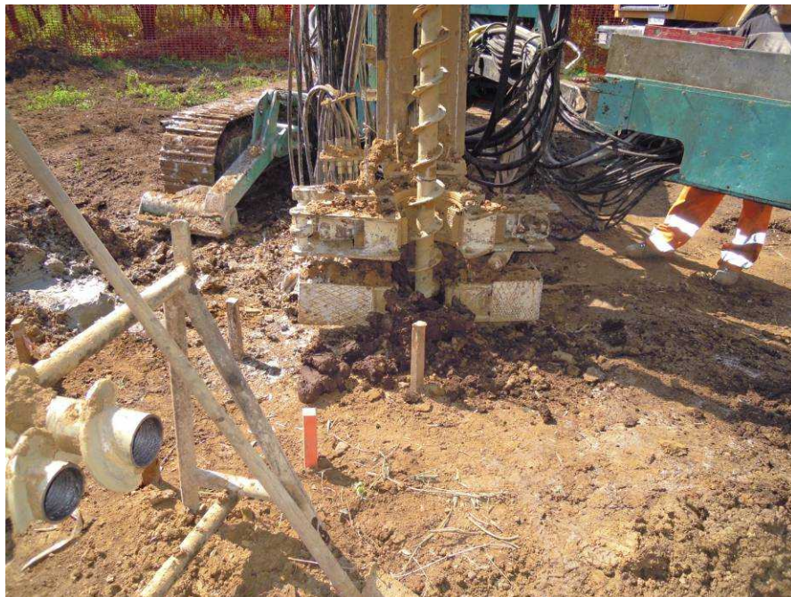
Macchina operatrice per la realizzazione di micropali tubfix; sistema di scavo mediante trivella elicoidale (immagine d'archivio)
