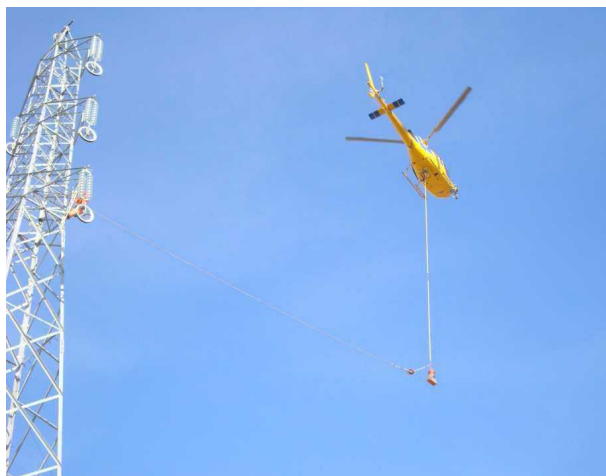
Utilizzo dell'elicottero per la stesura della fune pilota (immagine d'archivio)
