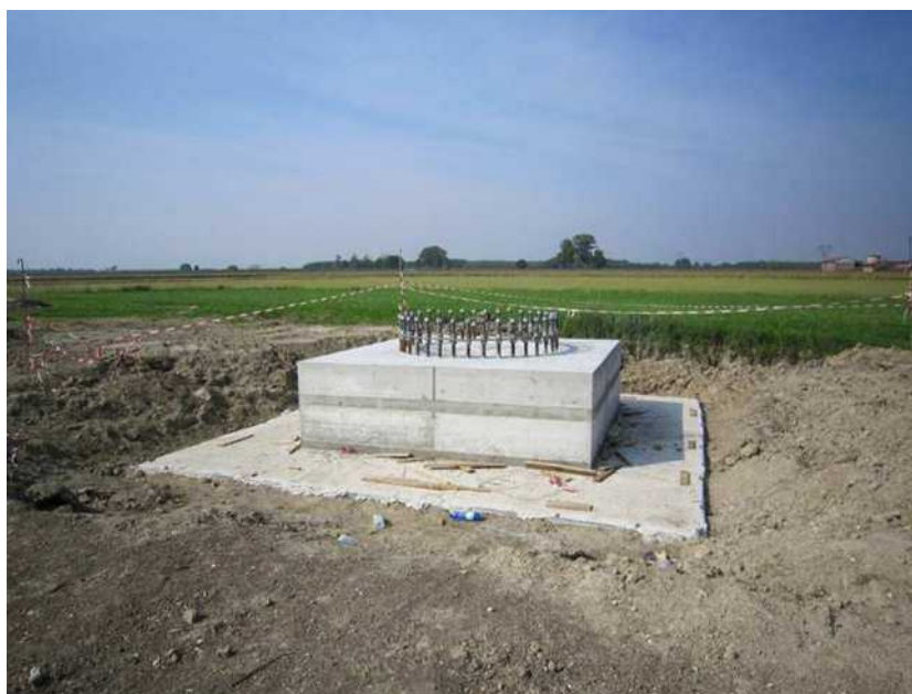
Realizzazione di fondazioni superficiali tipo plinto a monoblocco per un sostegno monostelo. Nell'immagine si può osservare una fondazione appena realizzata. Si può distinguere facilmente la flangia metallica dotata di tirafondi di raccordo con la parte in elevazione (immagine d'archivio)
