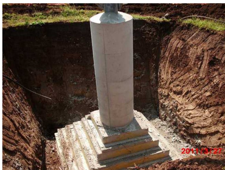
Realizzazione di fondazioni superficiali tipo CR per un sostegno a traliccio. Nell'immagine si può osservare una fondazione CR appena "scasserata". Si possono distinguere facilmente la parte inferiore a parallelepipedi tronco piramidali ed il colonnino di raccordo con la "base" del sostegno (immagine d'archivio)
