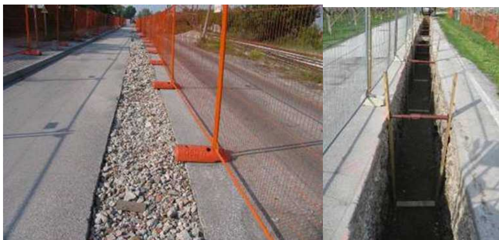
Taglio dell'asfaltatura e scavo aperto (immagine d'archivio)
