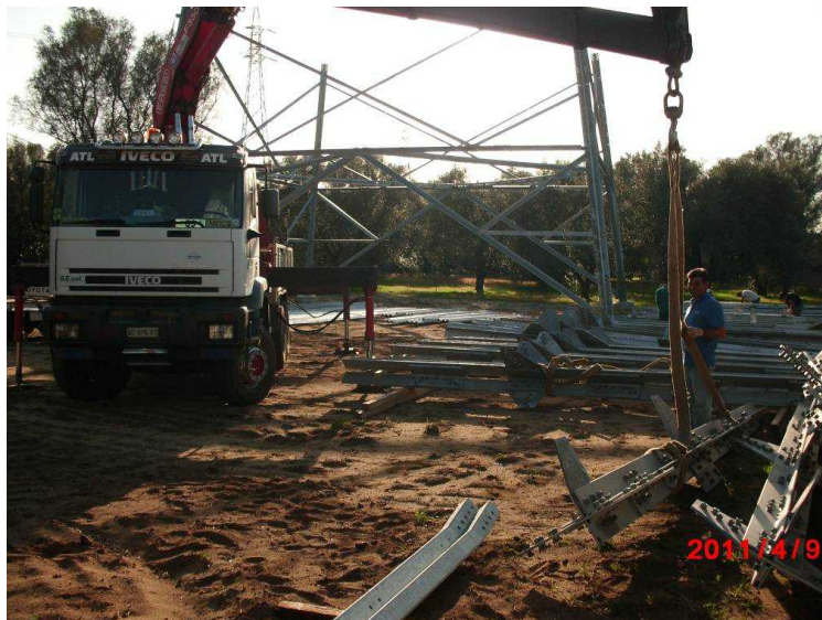
Fasi di montaggio sostegno a traliccio (immagine d'archivio)
