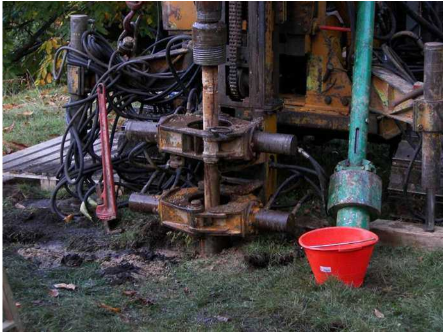
Macchina operatrice per la realizzazione di micropali tubfix; sistema di scavo a rotoperussione (immagine d'archivio)
