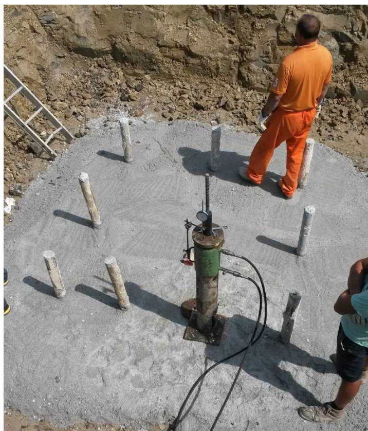
Realizzazione di micropali tipo tubfix per un sostegno a traliccio; si possono osservare i 9 micropali già realizzati ed iniettati; in questa fase, prima dell'armatura e cassetatura del plinto di fondazione, si sta eseguendo una prova di tenuta del micropalo allo strappamento, al fine di verificare la corretta progettazione e realizzazione dello stesso (immagine d'archivio)
