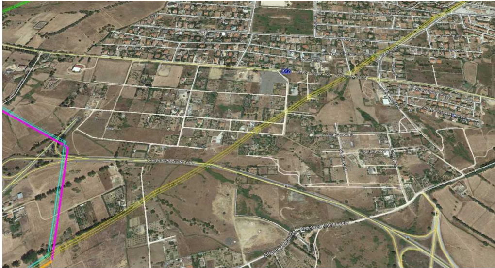
Linea "Siniscola – Taloro" (in giallo) – particolare tratto in demolizione
