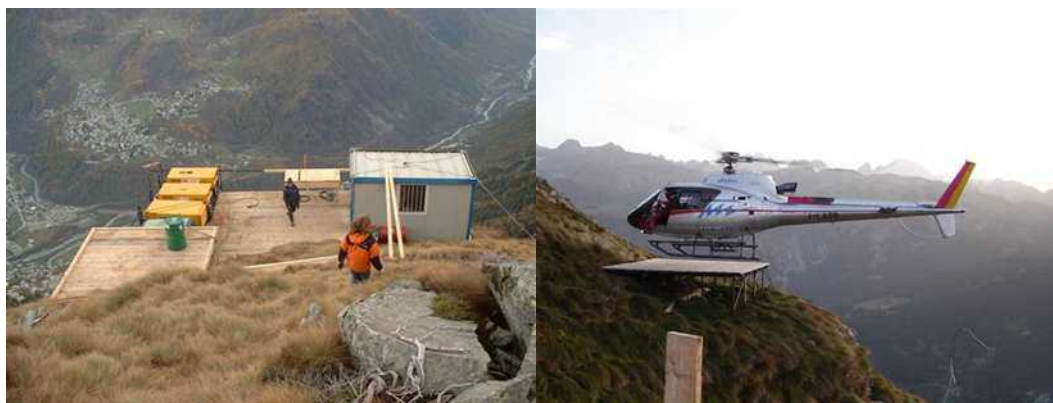
Esempi micro - cantieri in quota (immagine d'archivio)
