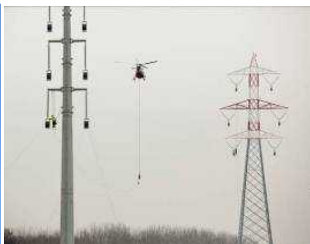
Utilizzo dell'elicottero per la stesura della fune pilota (immagine d'archivio)
