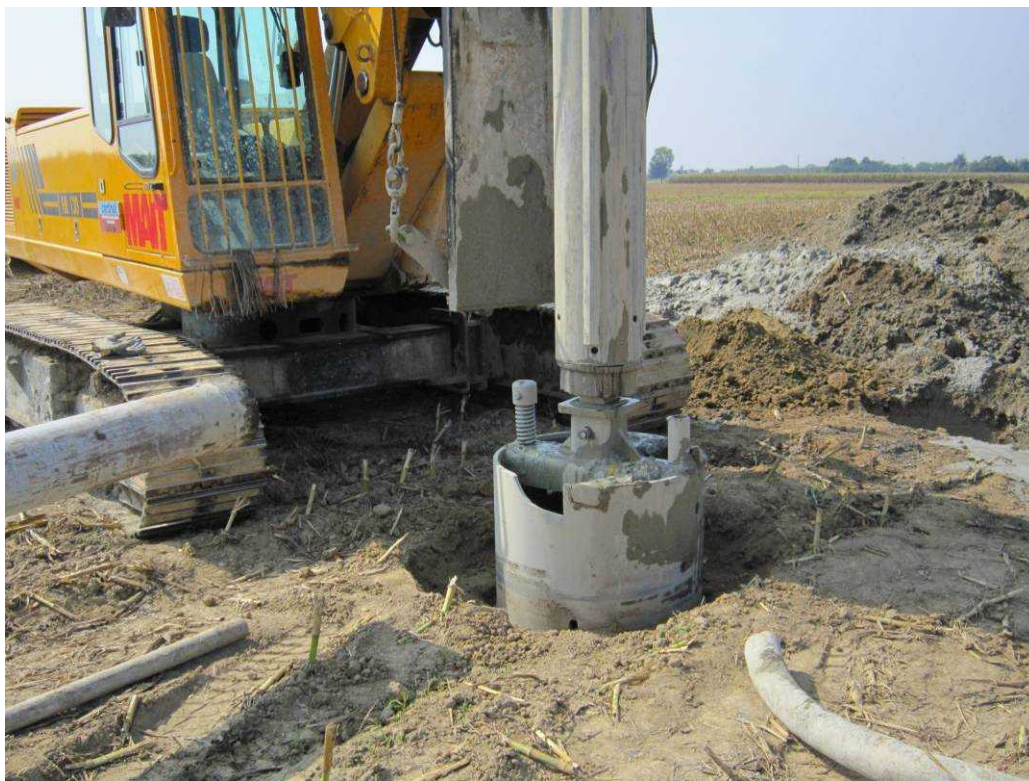
Macchina operatrice per la realizzazione di pali trivellati. Particolare del “carotiere” (immagine d’archivio)
