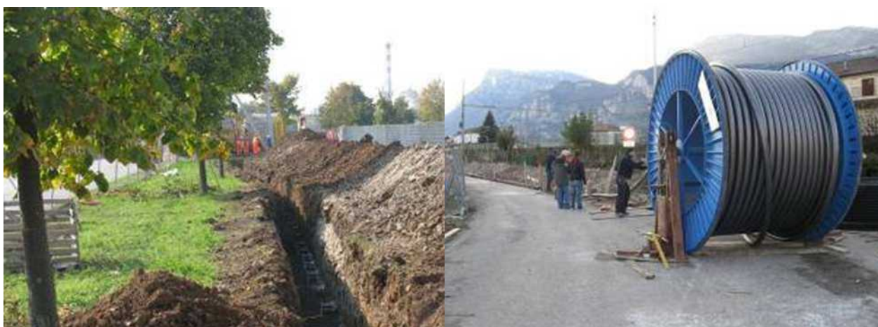
Posa rulli lungo lo scavo e stendimento del cavo (immagine d'archivio)
