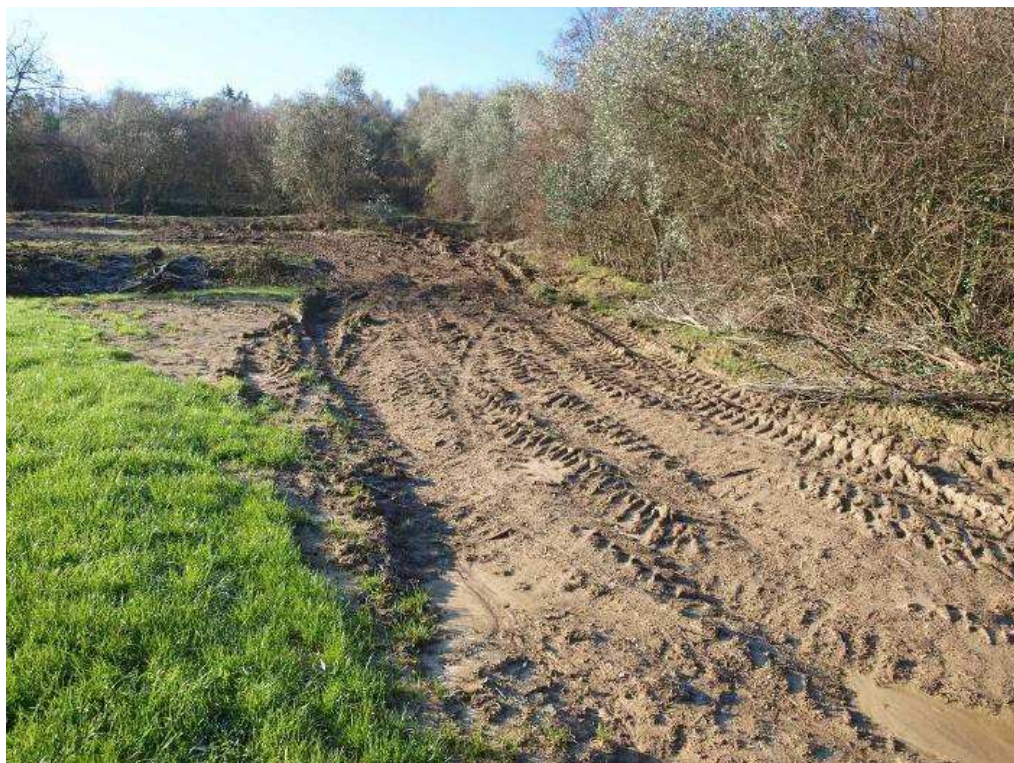
Le piste di accesso ai micro-cantieri dei nuovi tralicci verranno ripristinate a fine lavori.
