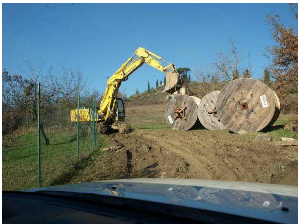
Trasporto dei conduttori tramite piste temporanee che vanno poi ripristinate a fine lavori.
