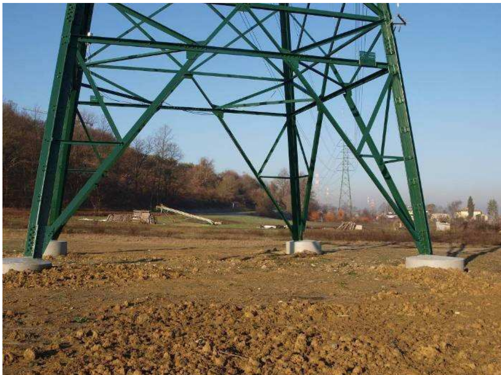
Va effettuata la sistemazione dei suoli interessati da realizzazione di nuovi tralicci/sostegni monostelo in zona di seminativo. Le dimensioni del traliccio rendono possibile l'accesso delle macchine agricole anche sotto il sostegno stesso.
