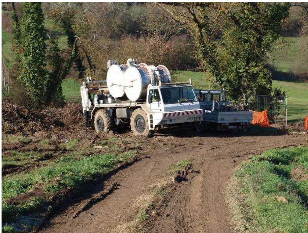
Idem c.s. (postazione di lavoro per tesatura conduttori).
