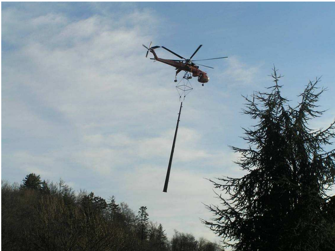
Trasporto di un sostegno con elicottero Erickson Air Crane S-64.
