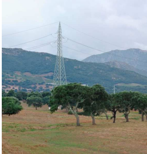
Sostegni a traliccio
