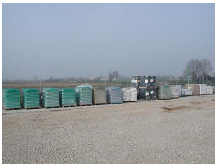
Figura 4.3.f – Stoccaggio in cantiere degli additivi chimici
