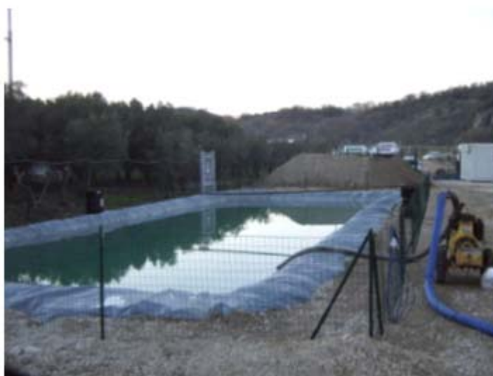
Figura 4.3.e – Vascone per lo stoccaggio in cantiere dell’acqua industriale
