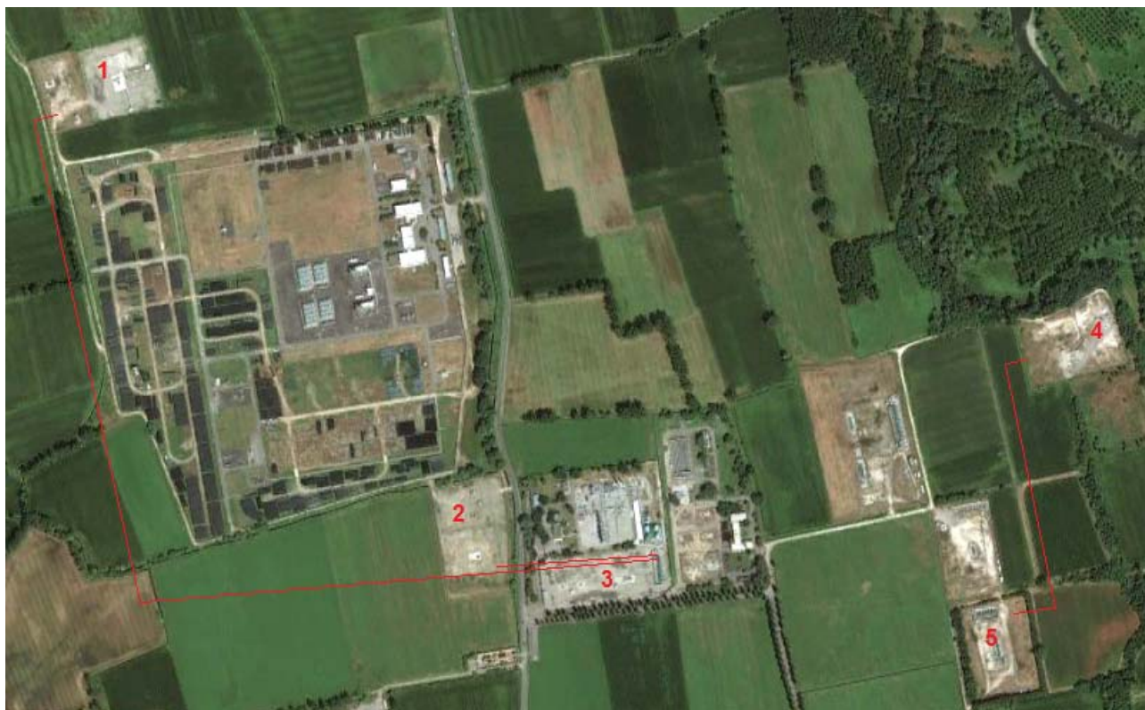
Figura 3.1.i – Tracciato indicativo delle nuove condotte di collegamento nuovi pozzi-cluster A e D (1 area pozzi Ripalta 6-62 e nuovo pozzo Ripalta 65Or; 2 area pozzi Ripalta 5-32-63 e nuovo pozzo Ripalta 64dir; 3 cluster A; 4 area pozzi Ripalta 27-61 e nuovi pozzi Ripalta 66Or e 67Or; 5 cluster D) - base Google
