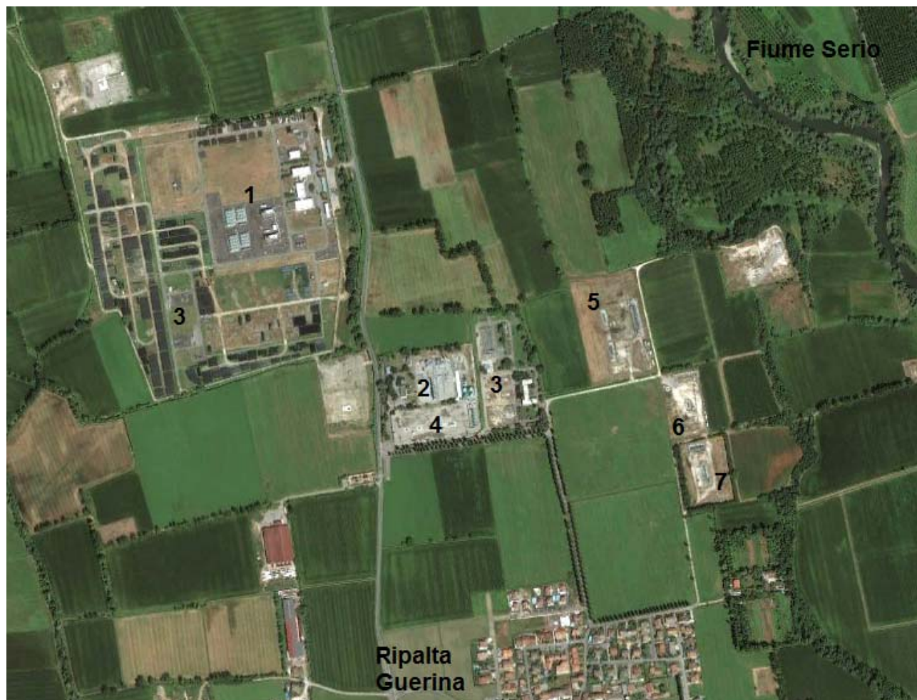
Figura 1.1.a – Principali infrastrutture della Concessione Ripalta Stoccaggio – situazione impiantistica attuale (base: Google Earth): (1) impianto (area) di compressione; (2) attuale impianto (area) di trattamento; (3) aree Snam Rete Gas; (4) cluster A; (5) cluster C; (6) cluster B; (7) cluster D
