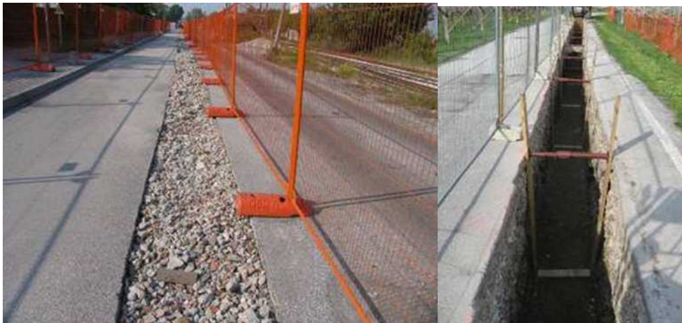
Taglio dell'asfaltatura e scavo aperto (immagine d'archivio)
