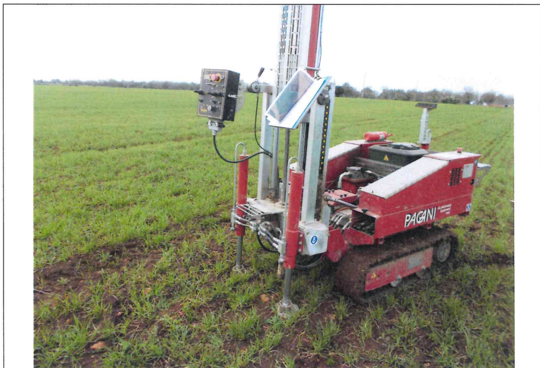
Esecuzione prova DPSH 2
