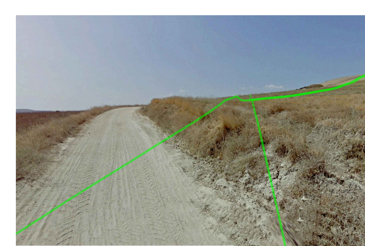
F1 - Strada di nuova realizzazione per accesso alla COL 01
