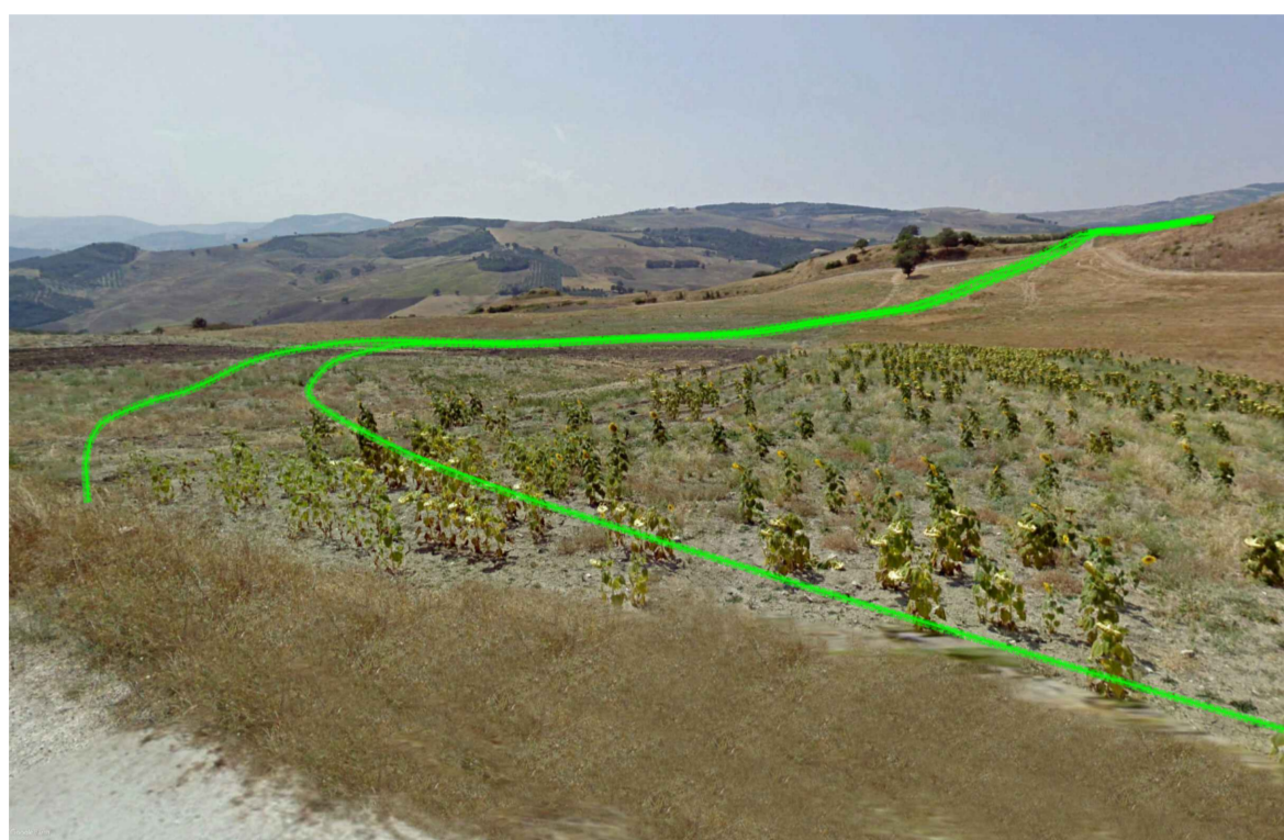
F7 - Strada di nuova realizzazione per accesso alla COL 04
