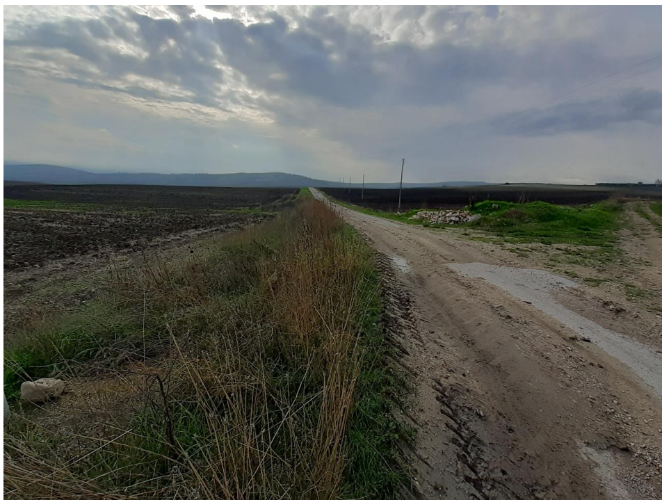
Figura 9. Immagine da sopralluogo int. 28
