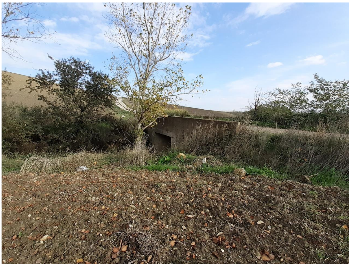
Figura 5. Immagine da sopralluogo int. 23.
