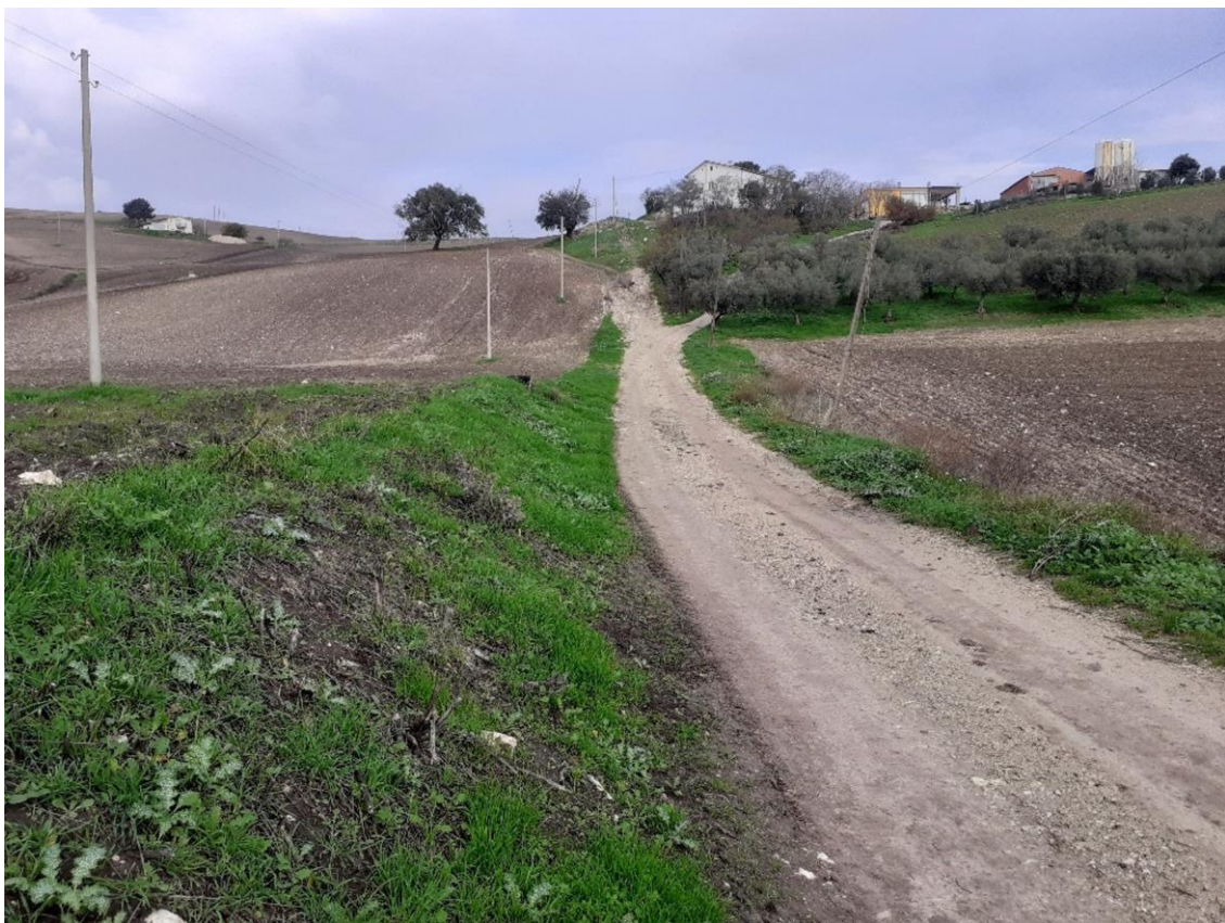
Figura 4. Immagine da sopralluogo int.19
