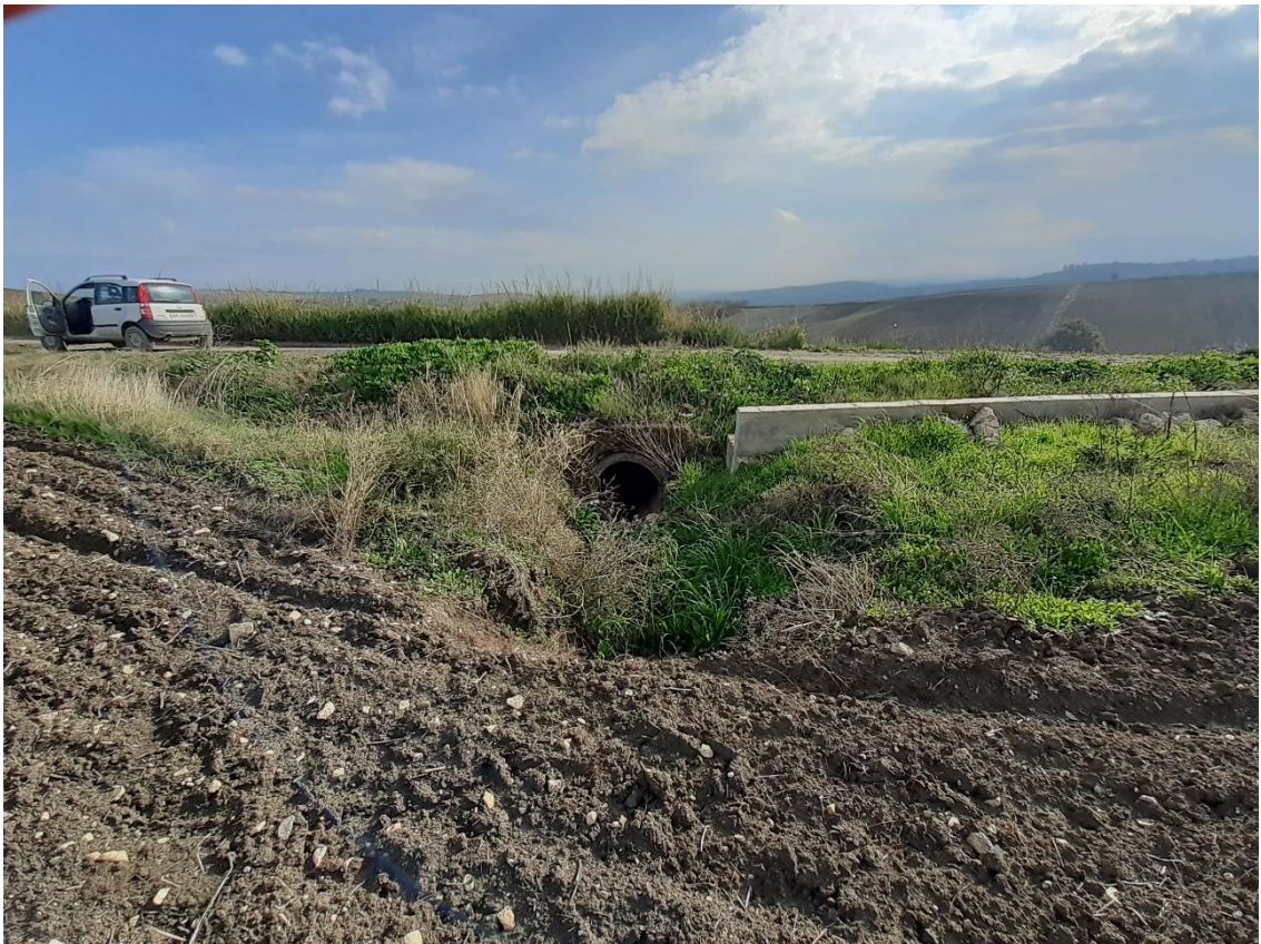
Figura 6. Immagine da sopralluogo int. 24.
