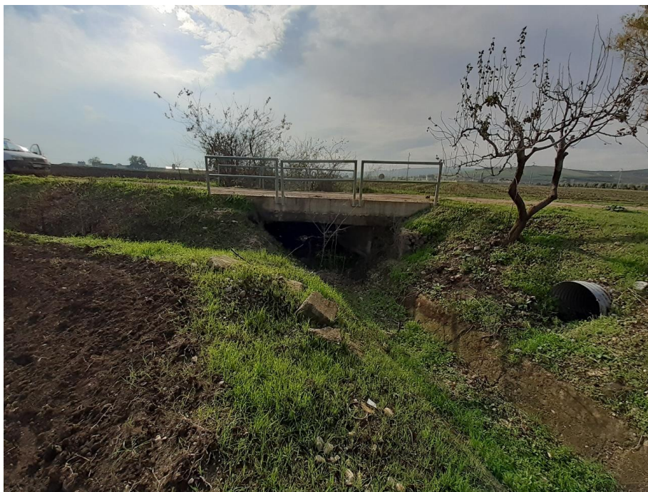
Figura 13. Immagine da sopralluogo int.35.
