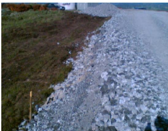
Figura 12: Superficie stradale in misto stabilizzato e drenaggio
