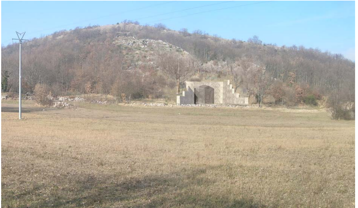
Figura 3.e: Impianto Idroelettrico, Imbocco della Galleria di Accesso alla Camera Valvole (predisposto Studio Architettonico)
