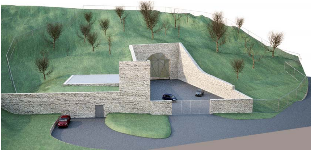
Figura 3.d: Impianto Idroelettrico, Imbocco della Galleria di Accesso alla Centrale (predisposto Studio Architettonico)
