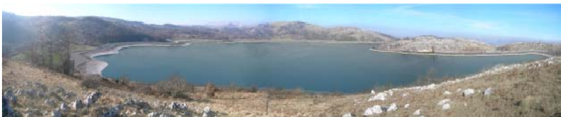
Figura 3.c: Impianto Idroelettrico, Bacino Superiore di Monte Alto
