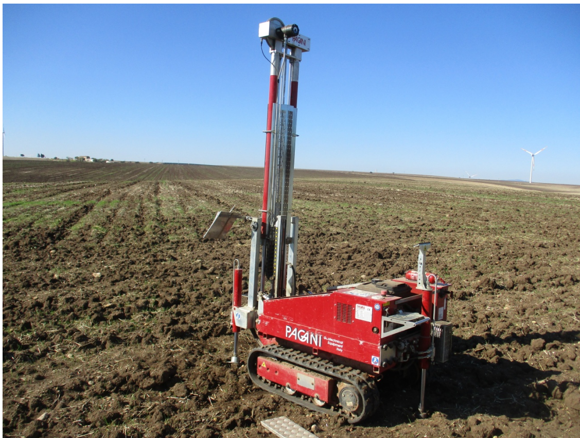
Esecuzione prova dpsh
