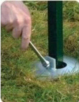
Fissaggio paletto al supporto di fondazione tramite vite filettata.
