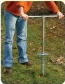
Messa in opera del supporto, tramite apposita chiave, dopo opportuna verifica della verticalità.
