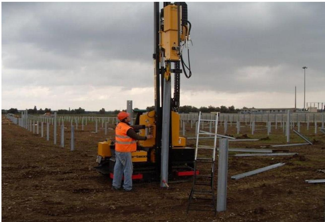
**Figura 1 - Rimozione palo con macchina operatrice**
