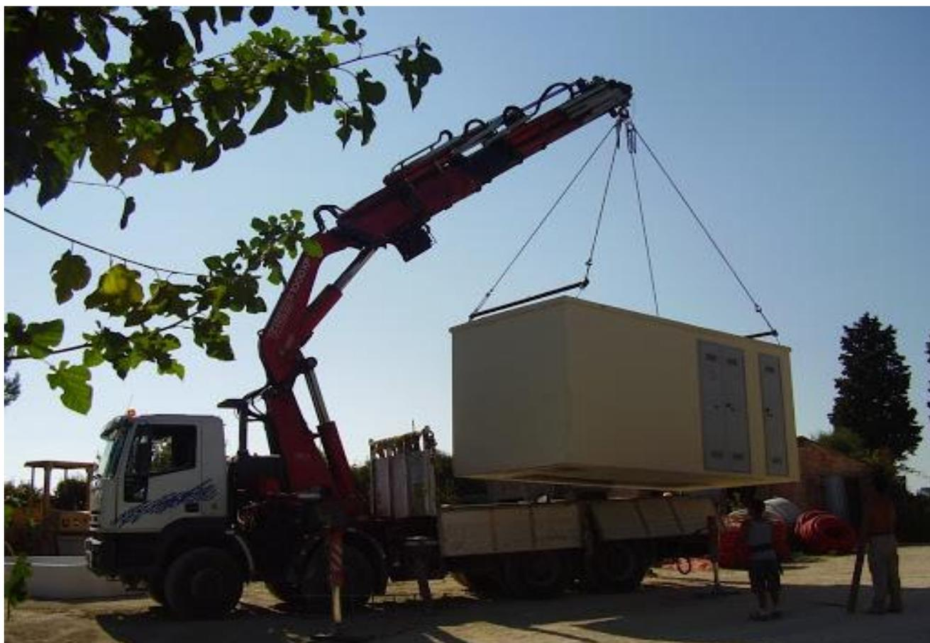
**Figura 2 - Smontaggio e rimozione cabine di campo**
