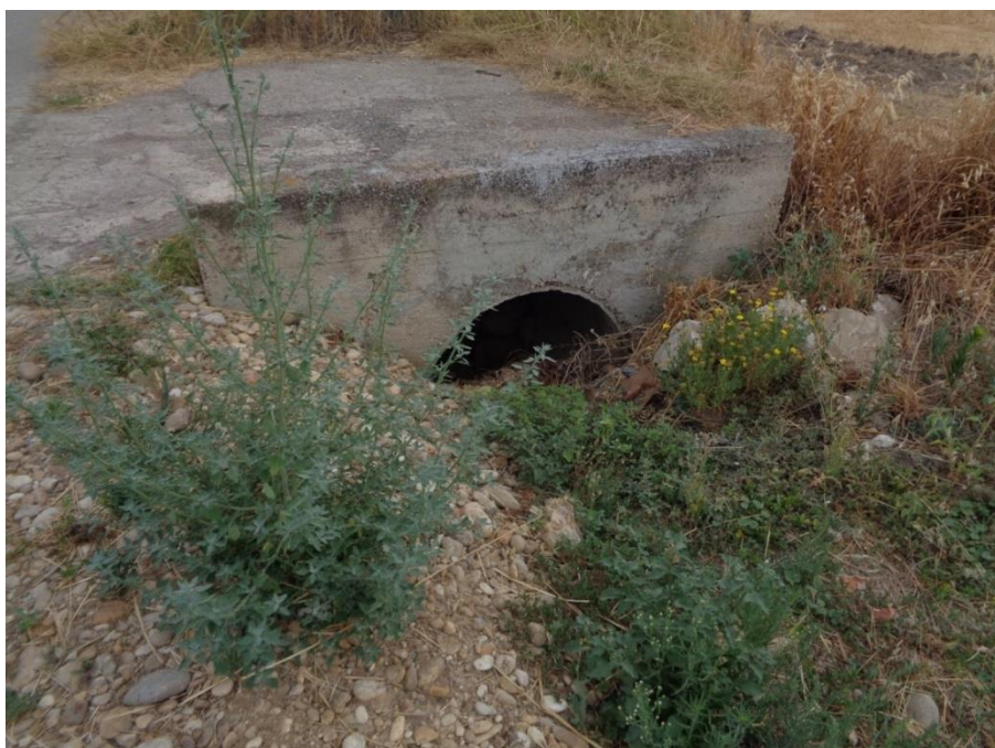
Figura 4 – Canale perimetrale sul lato Est – Nord Est
