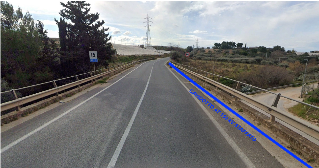
Foto interferenza INT_02 - staffaggio su ponte
