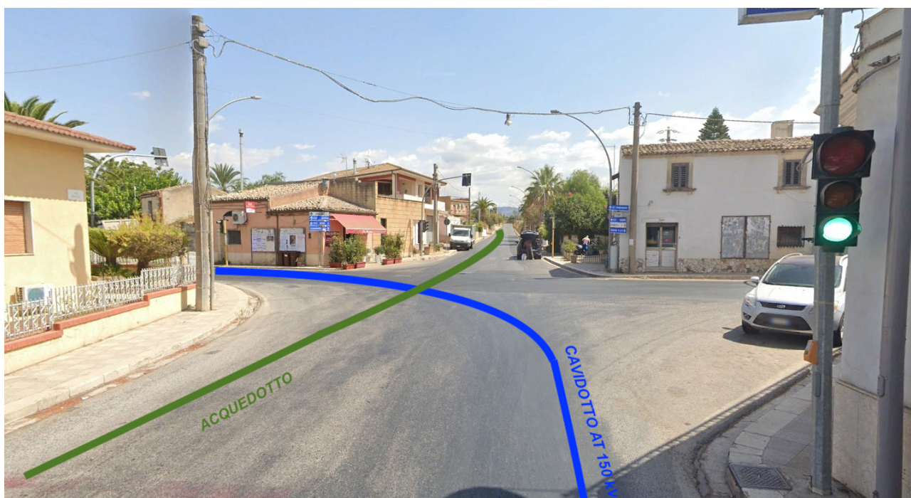
Foto interferenza INT_04 – incrocio condotta idrica
