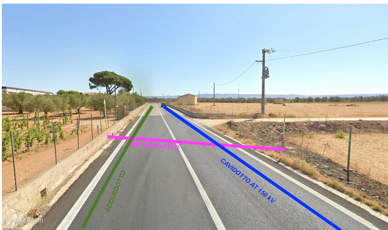
Foto interferenza INT_03 – incrocio tubazione gas
