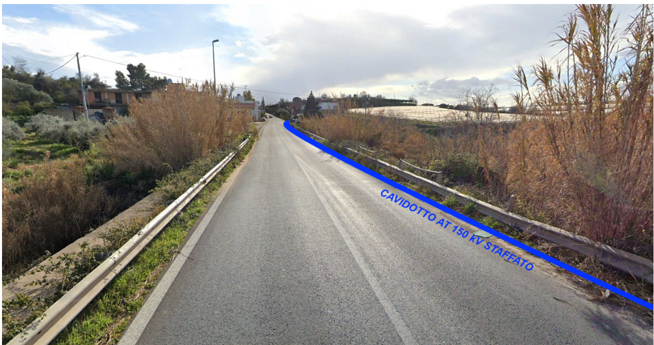
Foto interferenza INT_01 – staffaggio su ponte
