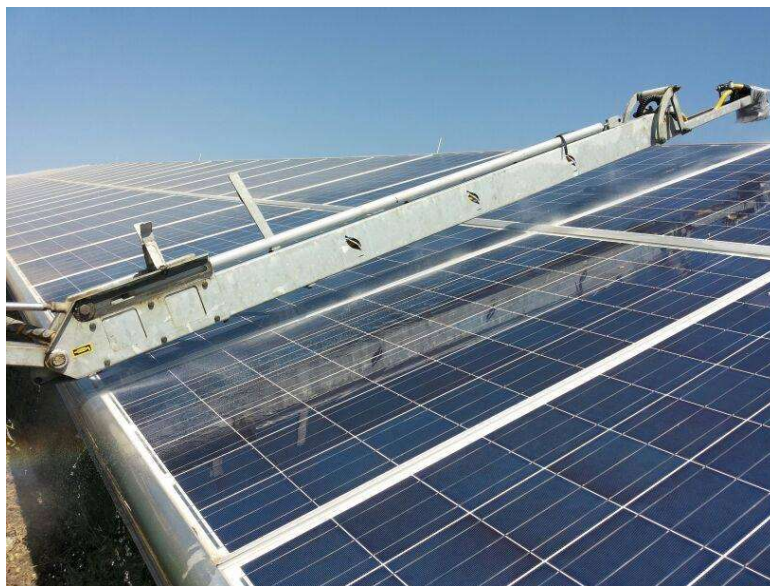
Figura 10 - Operazioni di pulizia moduli effettuate con sistema atomizzatore con uso esclusivo di acqua.
