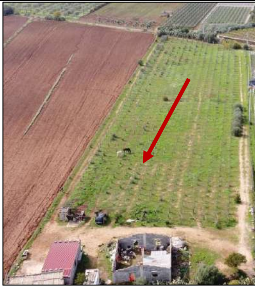
Vista da drone dell'UR 50 indicata con la freccia
