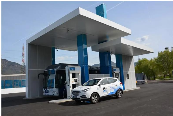
Stazione di distribuzione idrogeno
