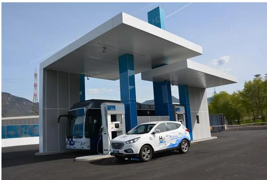
Figura 6 - Stazione di rifornimento
