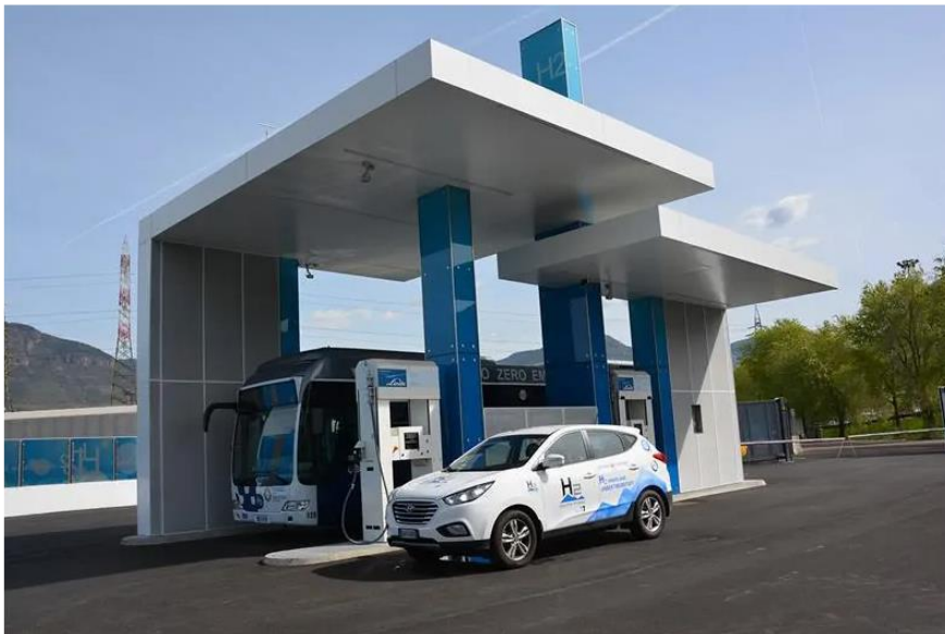
Figura 7 - Stazione di rifornimento
