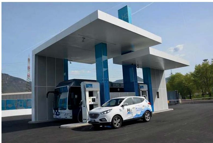
Figura 6 - Stazione di rifornimento
