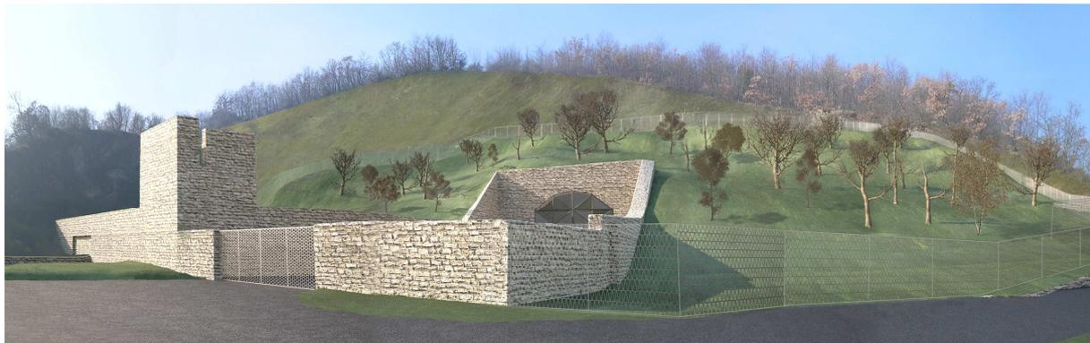
**Figura 6 – rappresentazione grafica dell’imbocco della galleria di accesso alla centrale**
