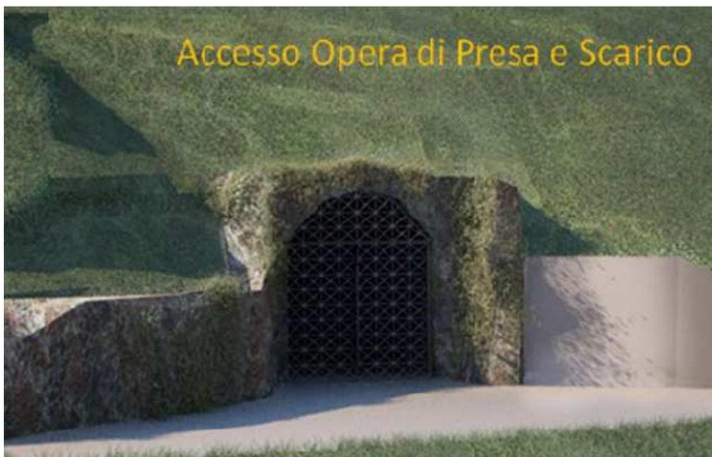
**Figura 4 – rappresentazione grafica dell’imbocco della galleria di accesso alla camera paratoie di monte oggetto di ripristino ambientale**
