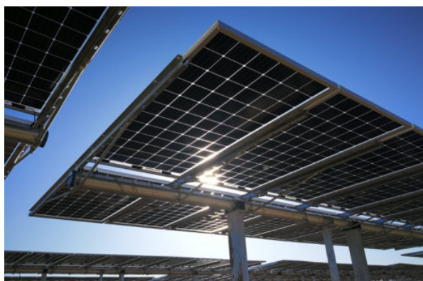
Figura 3.2: Esempio di struttura a tracker monoassiale
