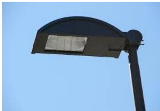
Figura 6.3: Esempio di apparecchio completamente schermato (full-cut-off).
