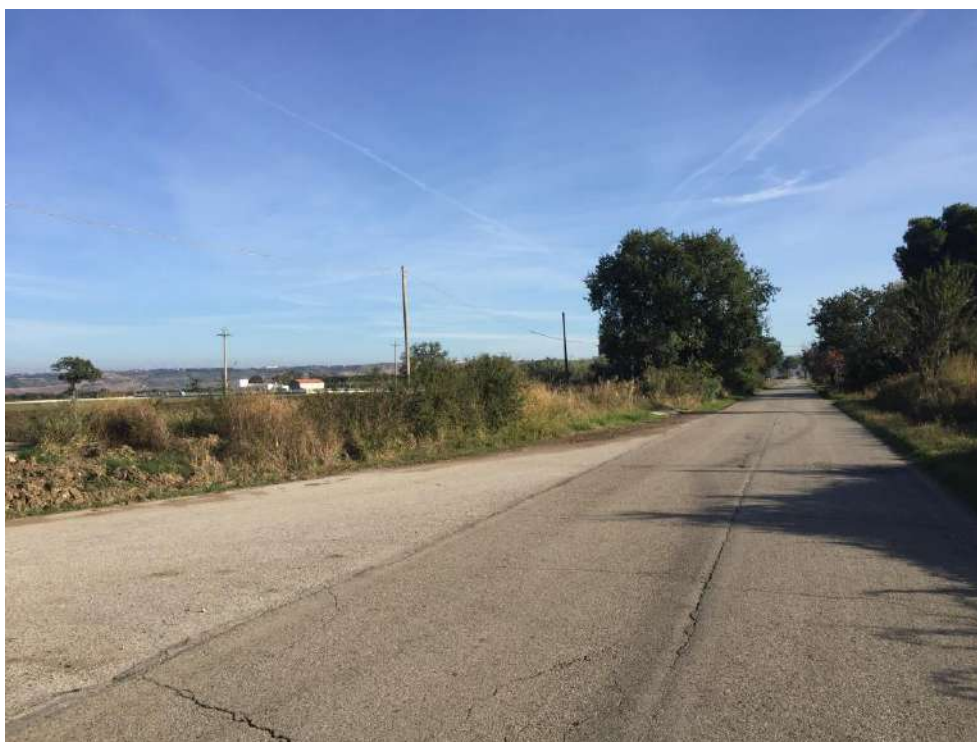
Figura 1: Stato di fatto
