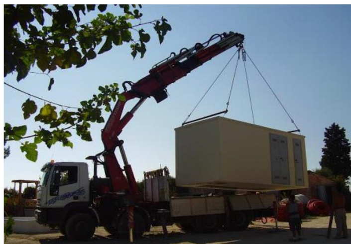
Figura 3: rimozione locali ausiliari
