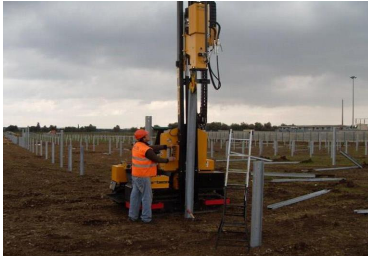
Figura 2: rimozione strutture di porta moduli
