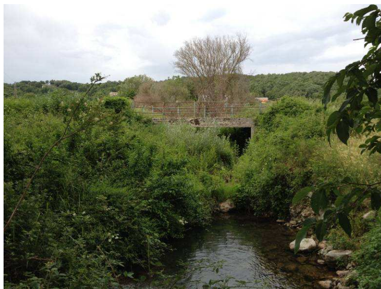
Figura 36 – Ponte 1 su Rio Secco
