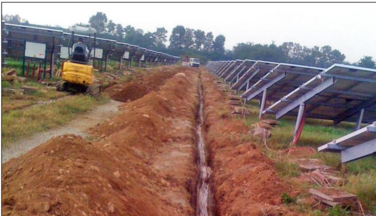
*Figura 16 – Tipico di scavo per cavi BT/MT*
