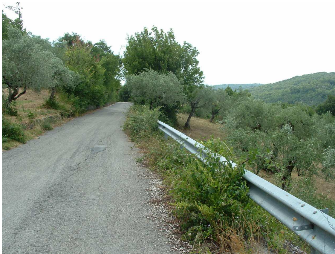
Figura 4 – Aspetto del pendio nei pressi del sostegno n. 13.
