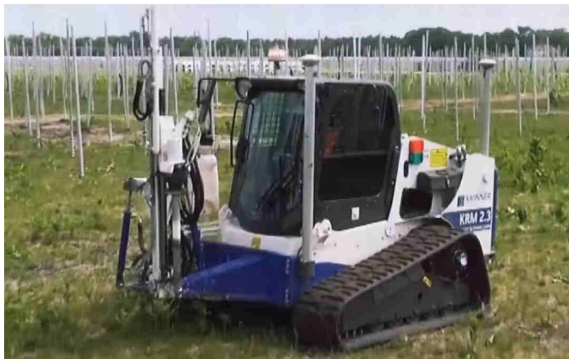
Fig. 51. Esempio di fissaggio delle strutture di supporto
