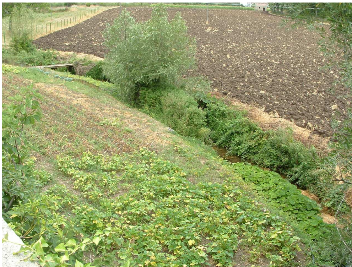
Figura 21 – Aspetto dell'alveo del Rio Secco nei pressi di Ponte Sorgenza (poco a monte della struttura).
