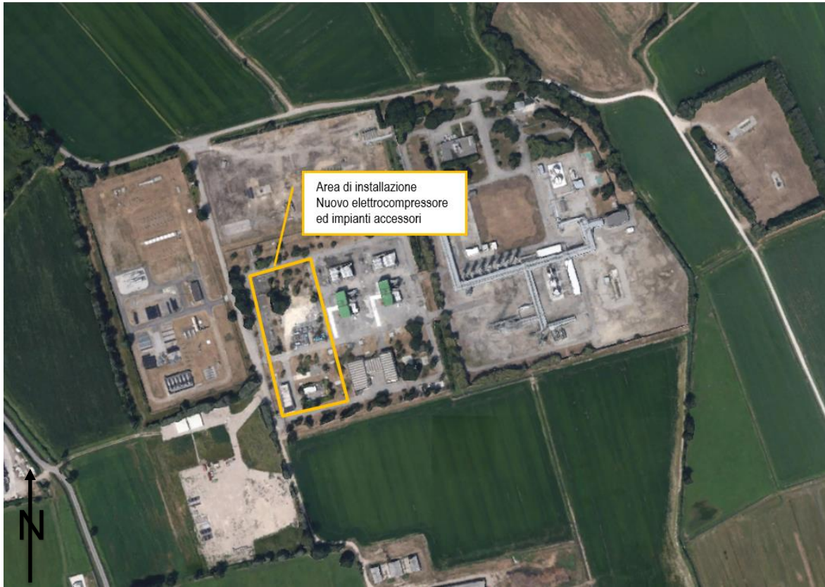
Figura 3: Zona di installazione nuovo elettrocompressore (interno Centrale)
