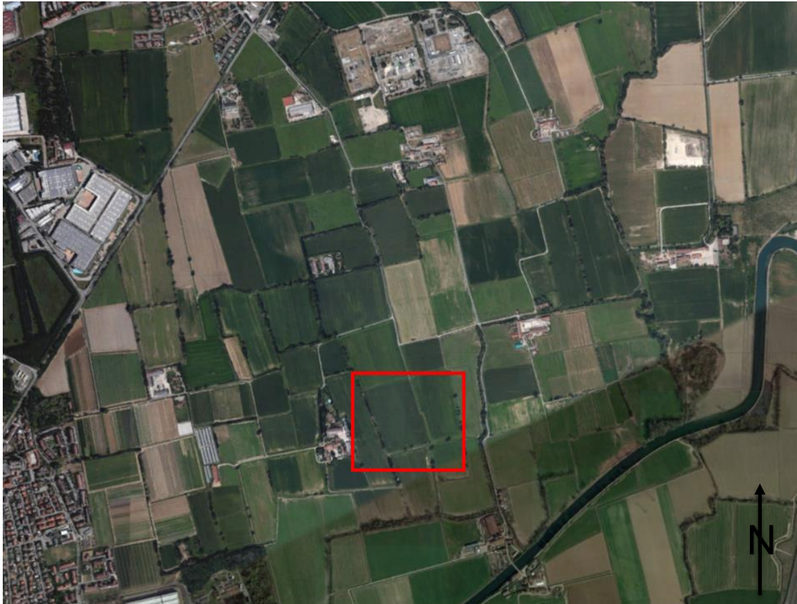
Figura 6: Aerofoto dell'area in oggetto nuove sottostazioni elettriche
