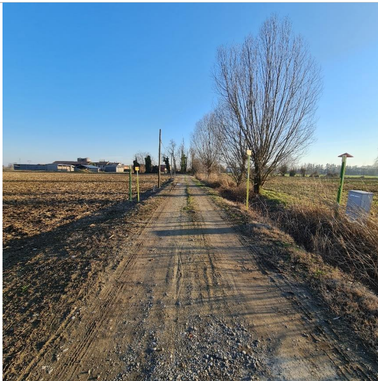
FOTO 10: Strada vicinale del boschetto, sotto a cui sarà posata la linea MT in cavidotto interrato (tratto finale verso Centrale STOGIT)
