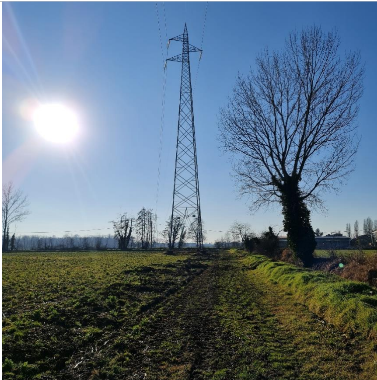
PUNTO DI RIPRESA 2: Area sottesa all'elettrodotto "Caleppio – Zelo Buon Persico" – tratto oggetto di demolizione, sulla destra, si noti un pioppo ed alcuni radi arbusti radicati sull'argine del canale .
