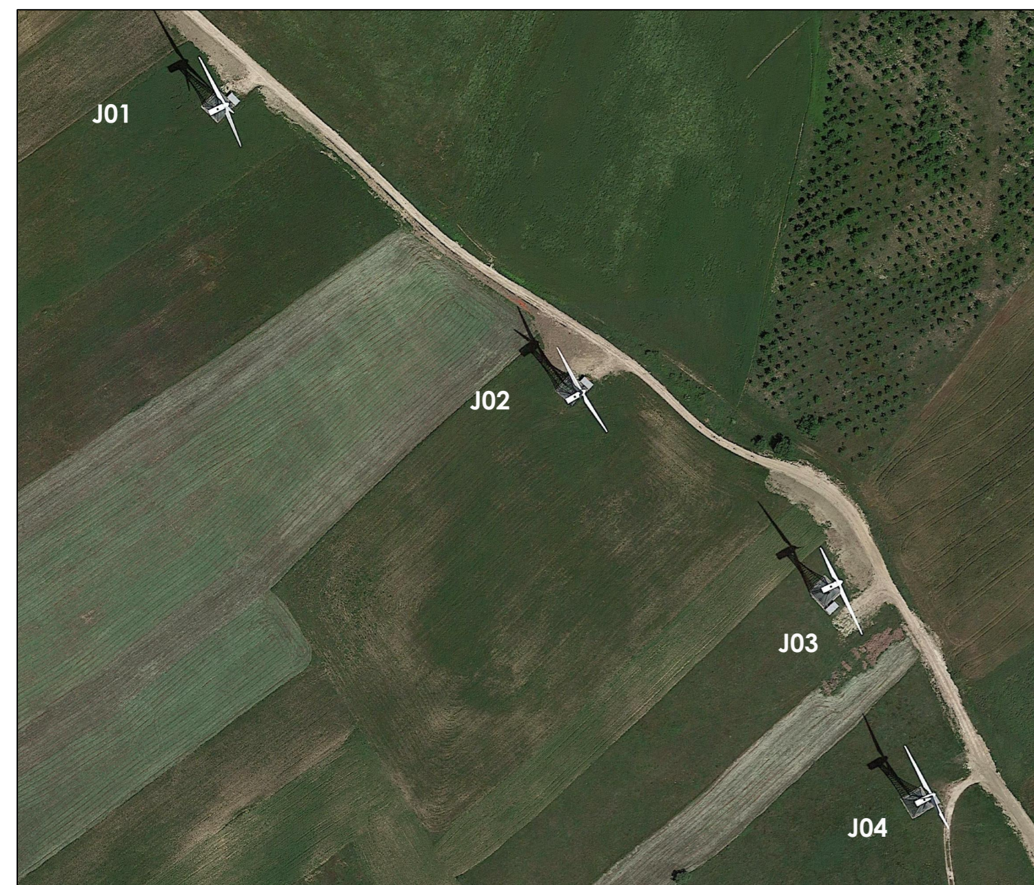
Ante Operam - Stato dei luoghi, aerogeneratori esistenti che saranno dismessi.
