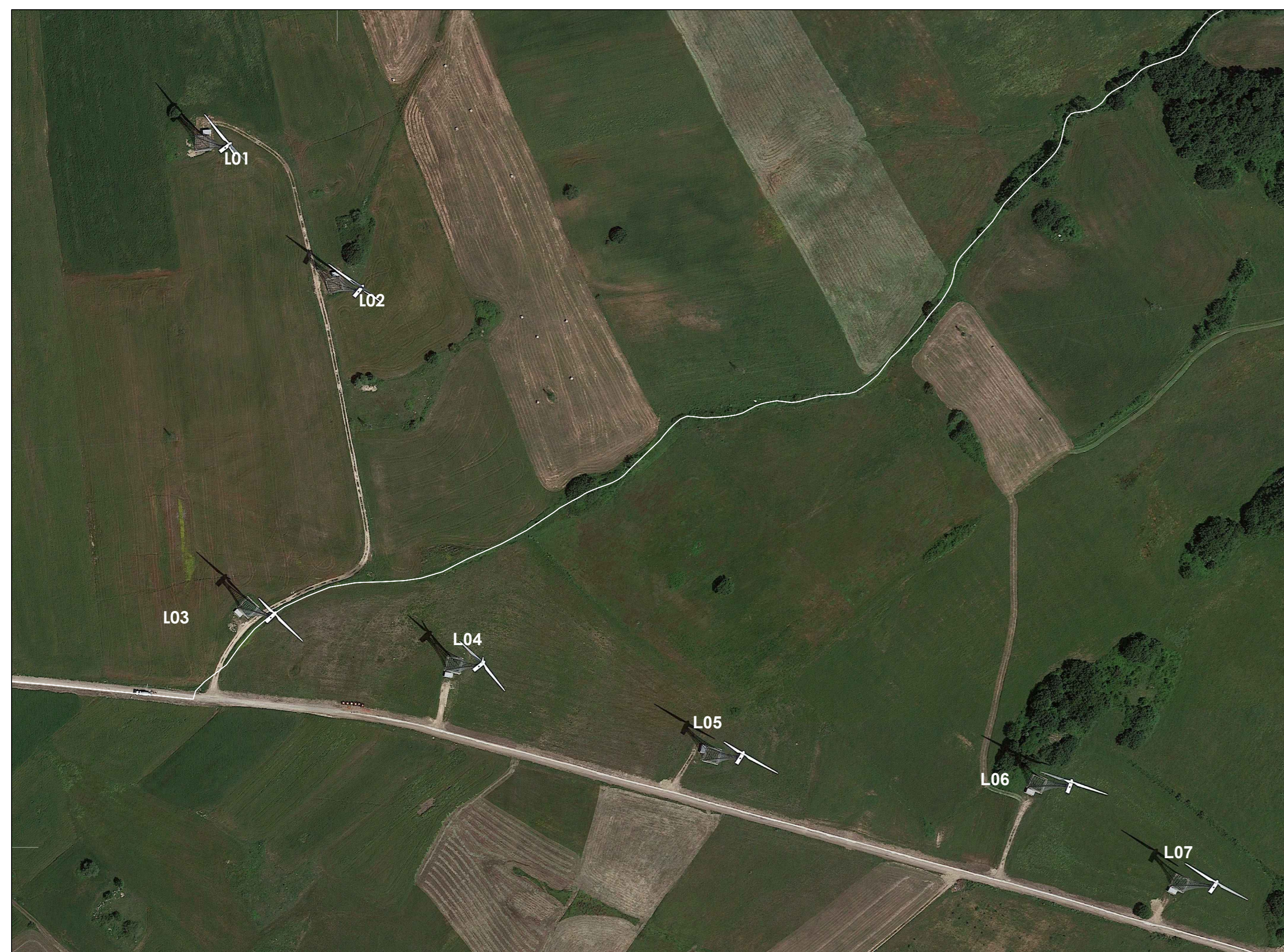
Ante Operam - Stato dei luoghi aerogeneratori esistenti che saranno dismessi
